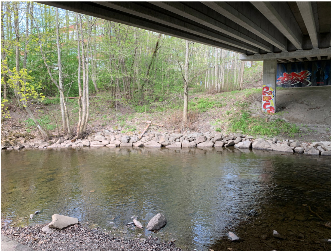
Figur 1-3: Ingen erosjon. Elva er plastret i ytterkant. Se punkt 1 i kart for plassering.
