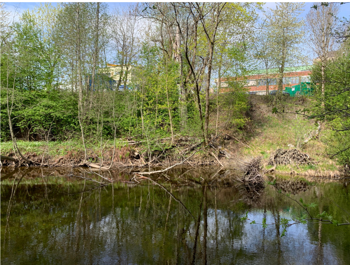
Figur 1-6: Litt erosjon. Noen trær står på skakke. Se punkt 4 i kart for plassering.
