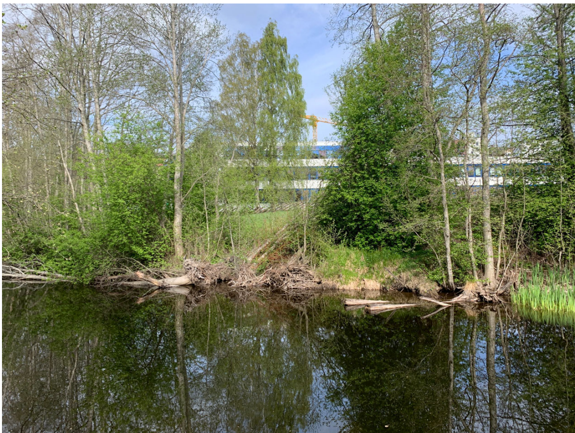
Figur 1-10: Litt erosjon. Noen trær har veltet (antatt på grunn av erosjon). Se punkt 8 i kart for plassering.
