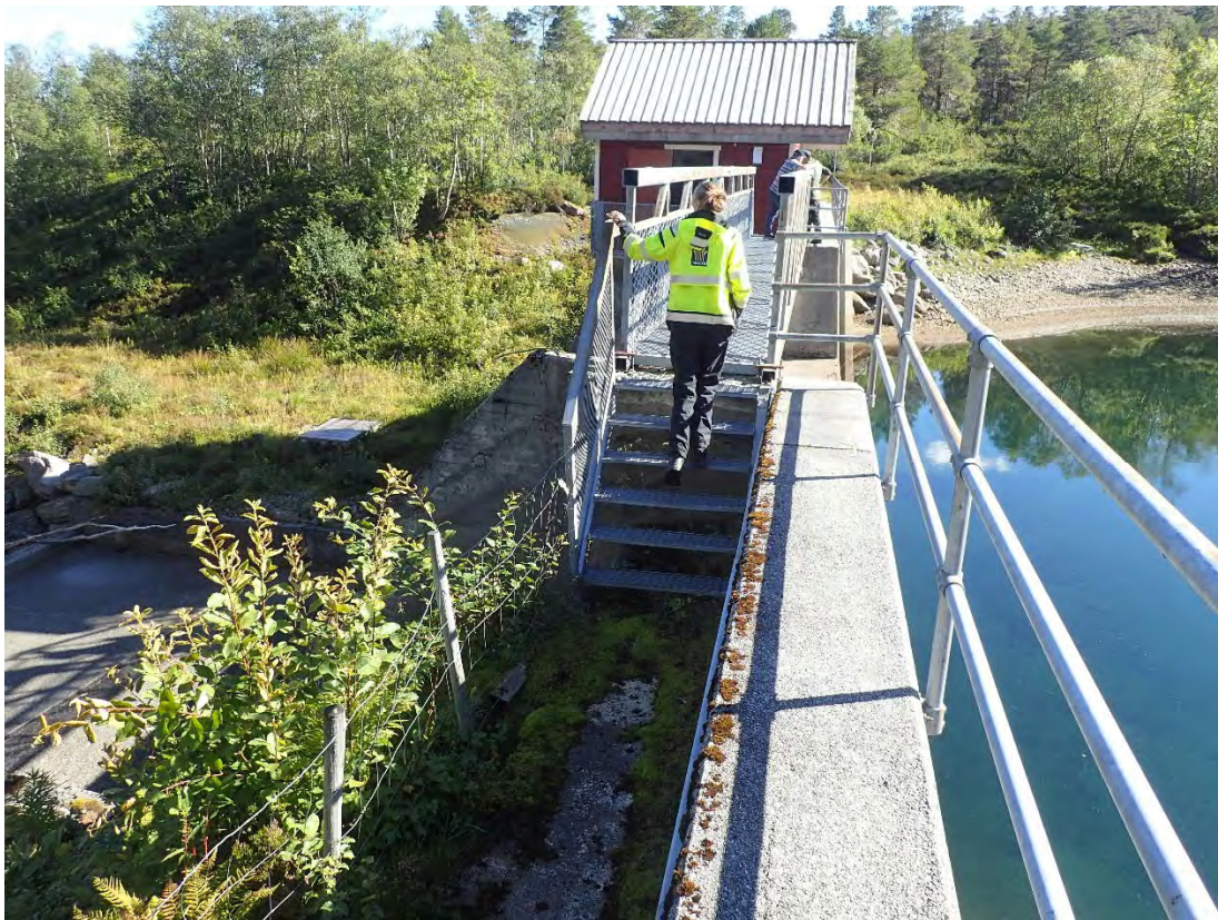
Bilde 3 - Damkrone med bro over overløp
