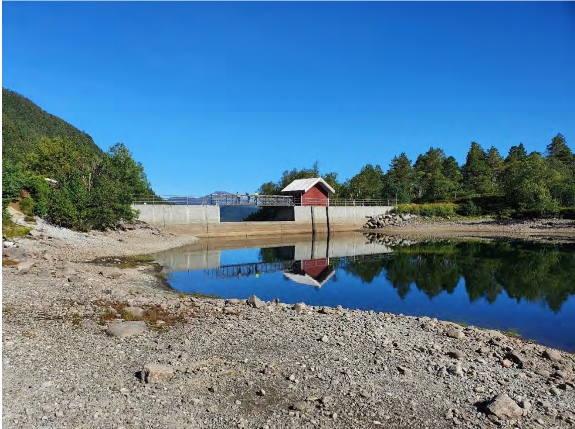
Bilde 1 - Dam Gamlestølsvatn. Oversikt fra oppstrøms side.
