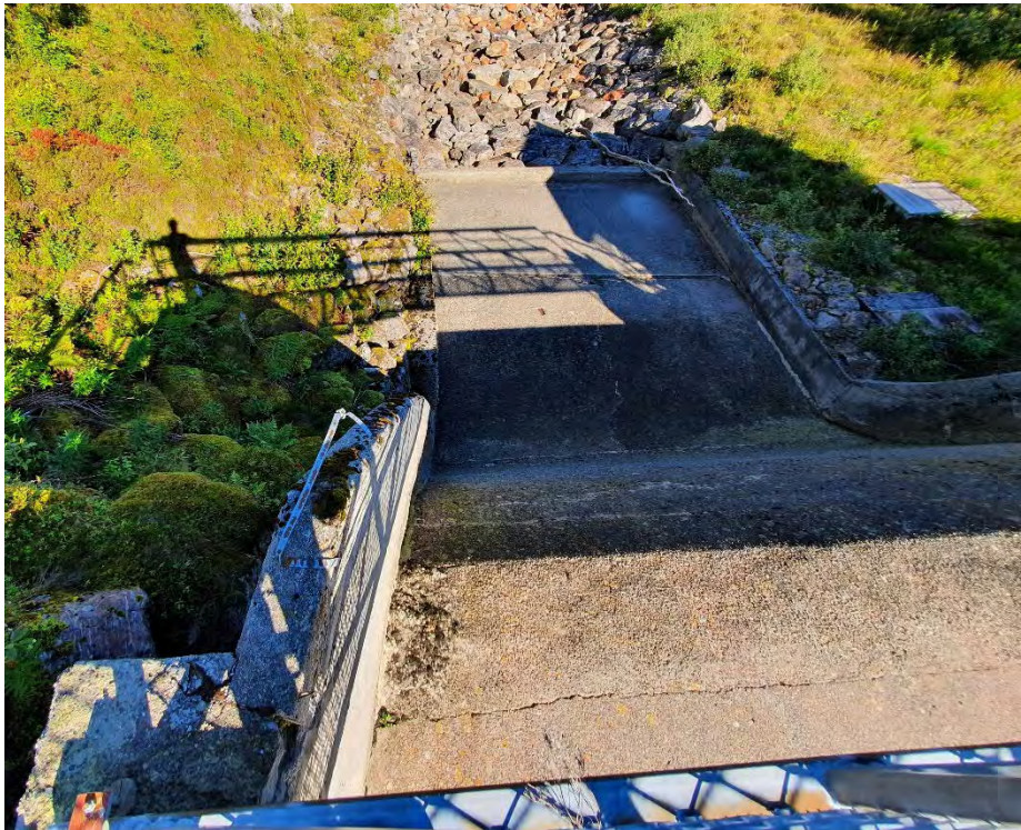
Bilde 5 - Overløp sett fra bro
