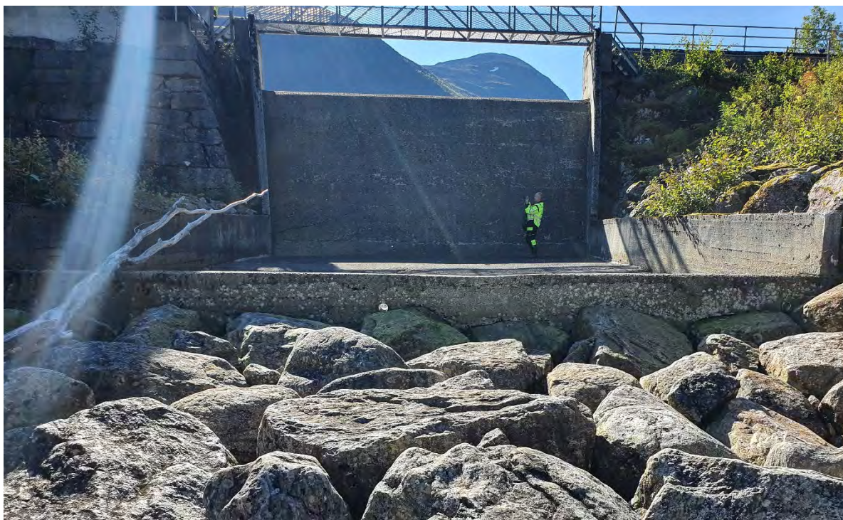
Bilde 7 - Overløp sett fra nedstrøms side
