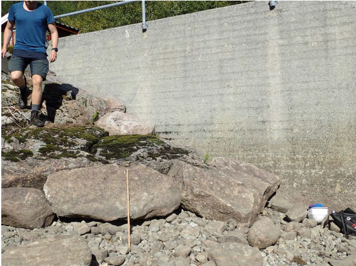
Bilde 2 - Oppstrøms side av landfeste
