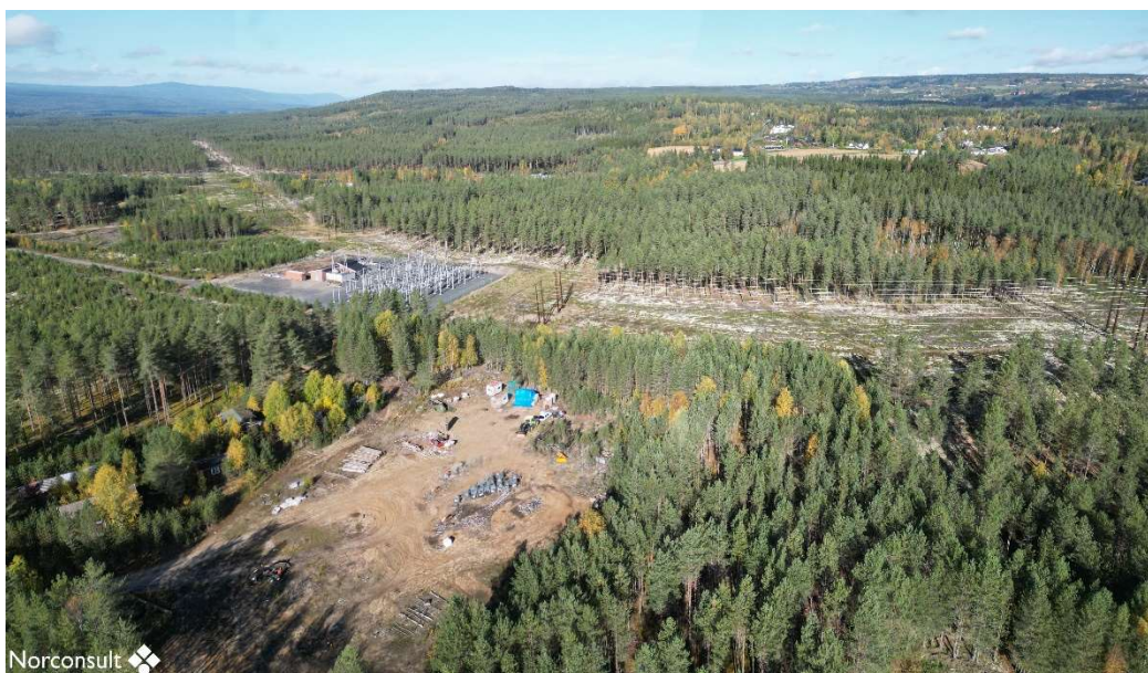
Figur 3-4 Område A. Bilde tatt i retning nord, med Løvbergsmoen transformatorstasjon i vest. (Foto: Norconsult).
