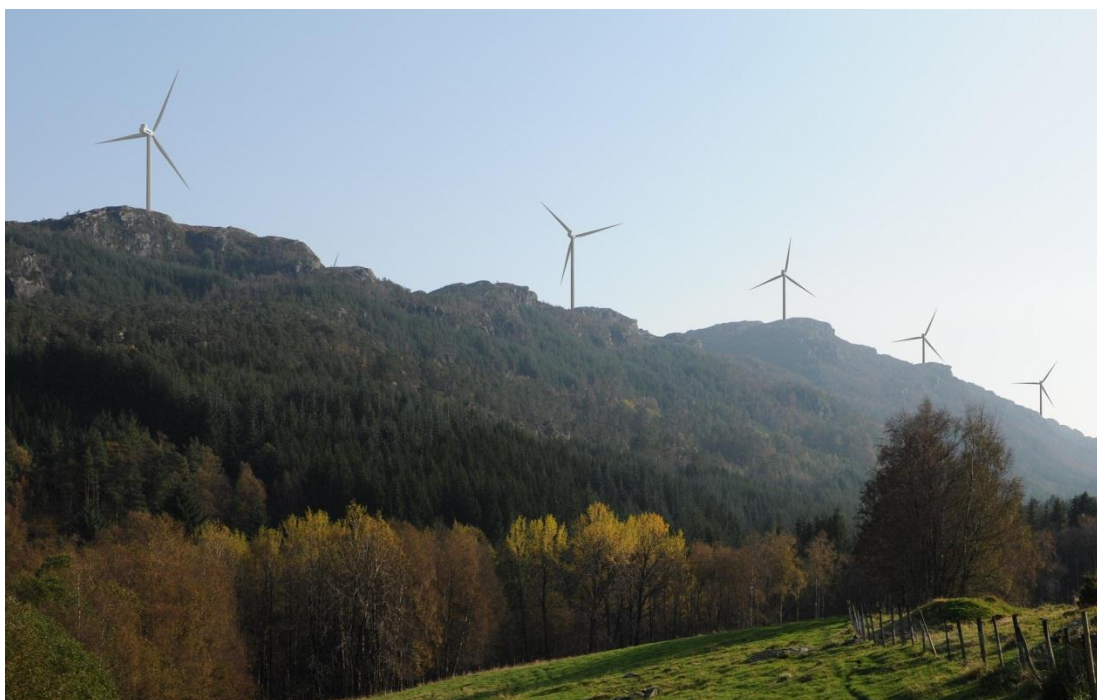
Figur 16. Utsikt fra Rotvoll i Viksdalen til Bukkanibba vindkraftverk i drift. Foto og visualisering: Norconsult.
