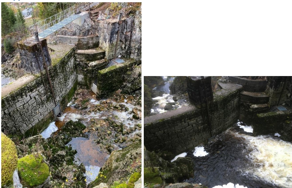
Figur 18. Foto av elva oppstrøms dammen til Gamle Finså kraftverk. T.v.: 18.oktober (Ingen slipp). T.h.: 20.oktober (slipp 75 l/s).
