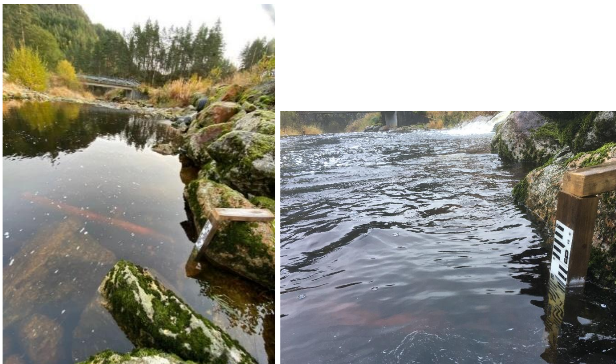
Figur 17. Bilder av bassenget ved Feed skianlegg der målestaven er plassert. T.v.: 18. oktober (målestav 67 cm). T.h.: 20. oktober (målestav 85 cm).
