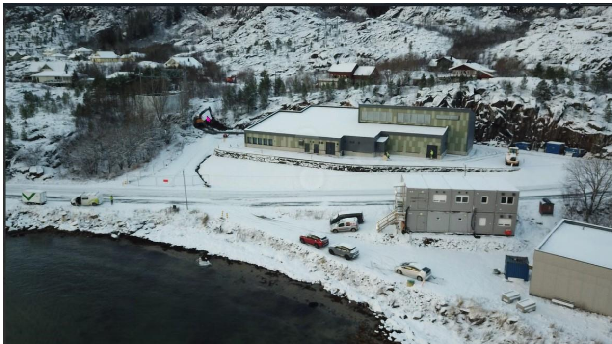
Figur 6: Lødingen transformatorstasjon. Til venstre sees eksisterende muffestasjon som rives.
