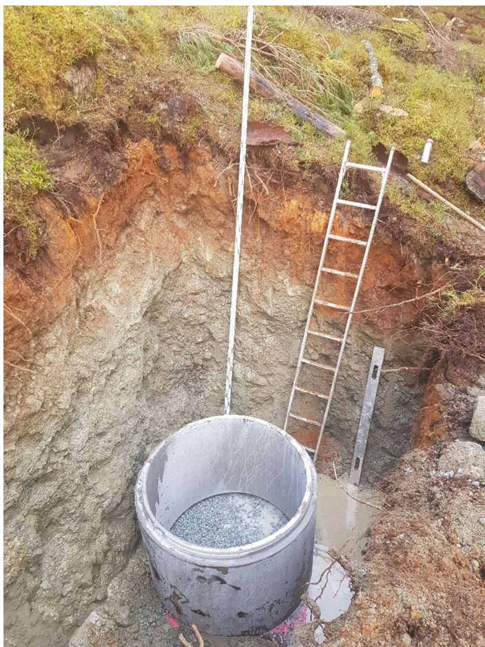
Figur 9. Eksempel på påbegynt rørfundament for komposittmast i løsmasser.
