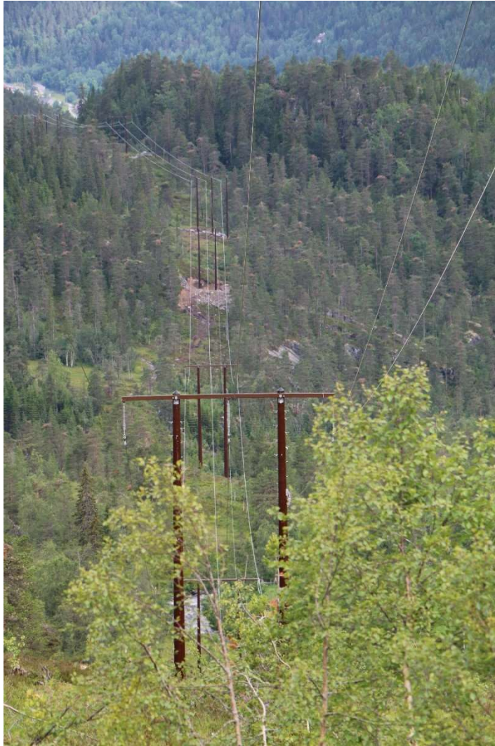
Figur 2. Komposittmaster av samme type på 132 kV kraftledningen Granvin – Voss.
