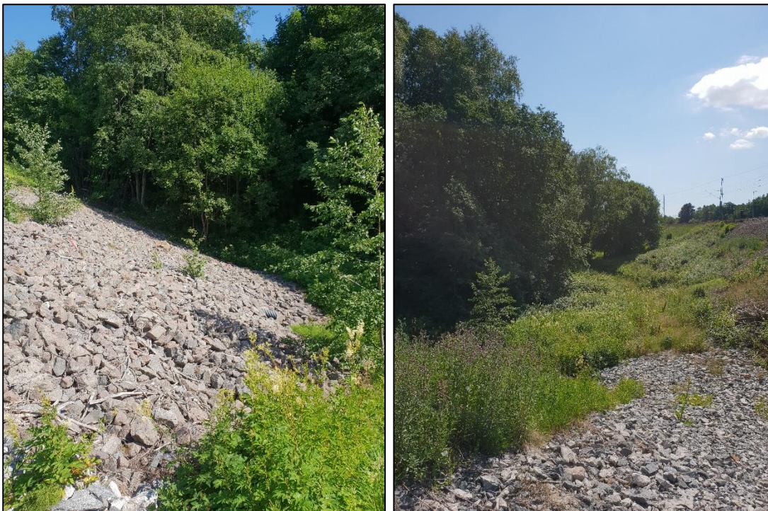
Figur 6.3 Venstre: Bilde tatt mot vest lengst sør ved fyllingsfot for parkeringsområdet etablert i 2007. Høyre: Bilde tatt fra samme punkt, mot sør. Jernbanefyllingen ses til høyre.
