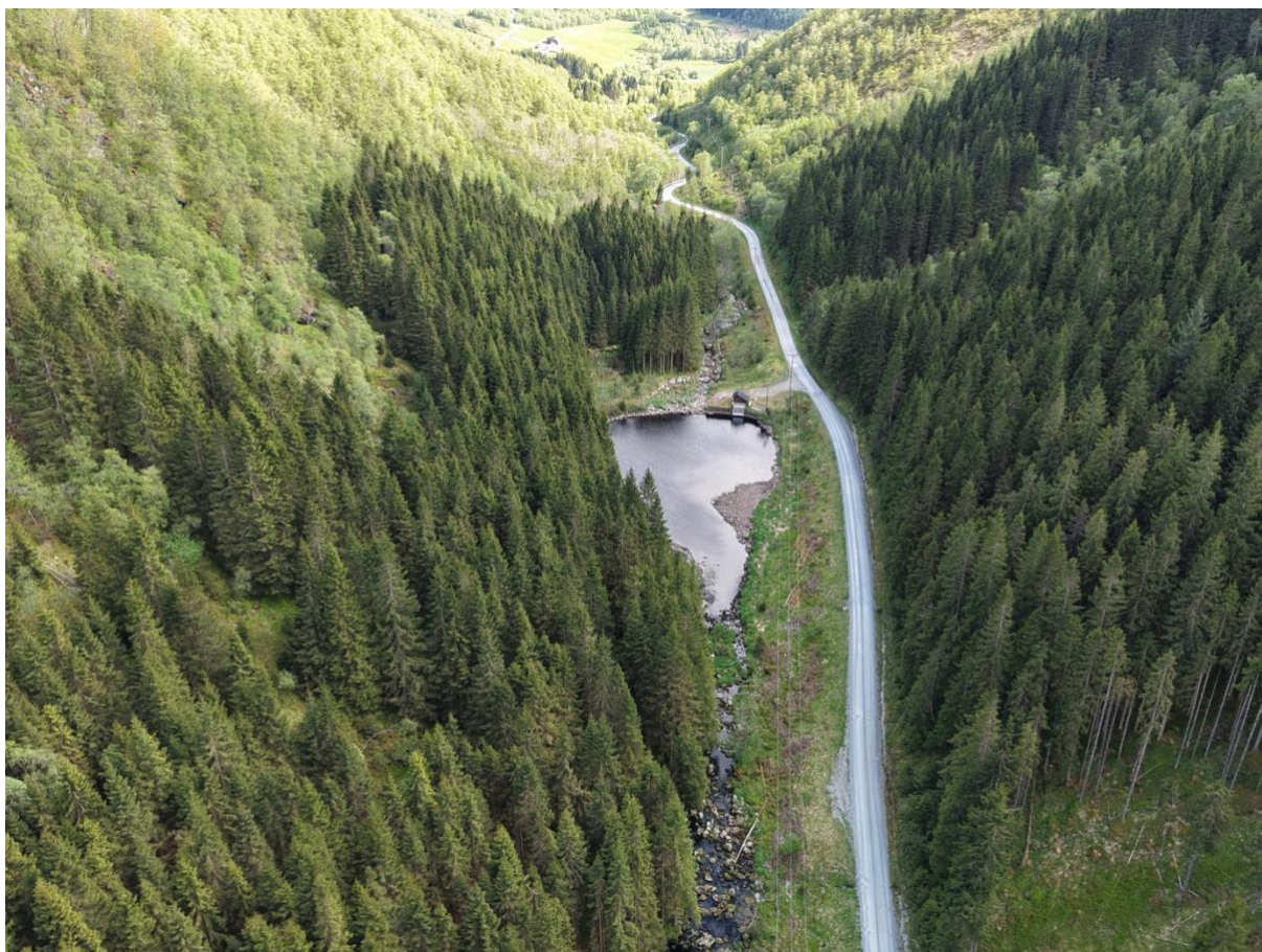
Figur 21: Deler av strekningen det vil være regulert vannføring nedstrøms Norddalsvatnet
