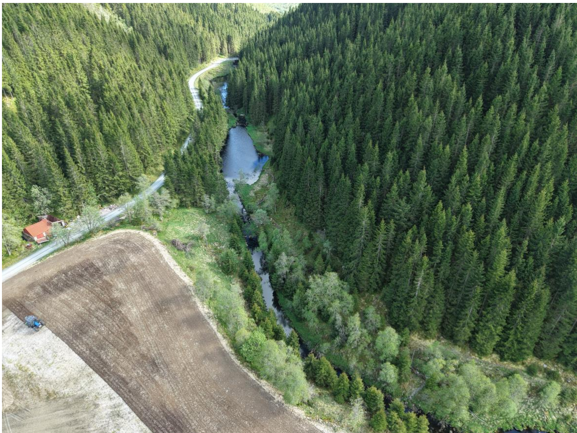
Bilde 4: Vannstekning oppstrøms Dalelva kraftverk
