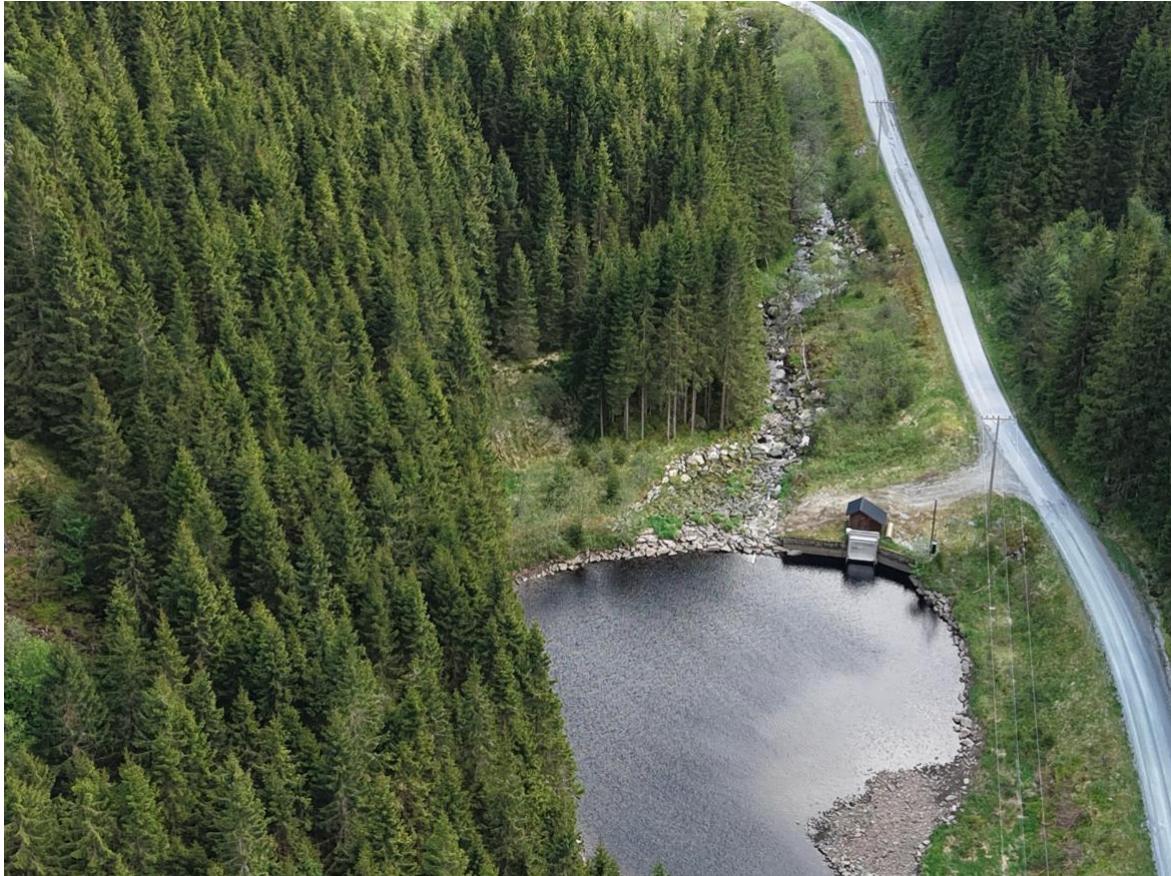
Bilde 1: Eksisterende inntak Dalelva kraftverk
