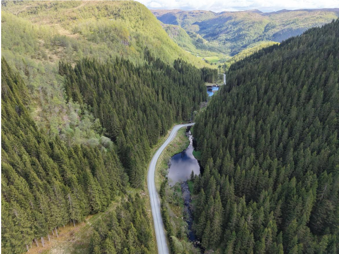
Bilde 3: Bilde 2: Vannstekning oppstrøms Dalelva kraftverk
