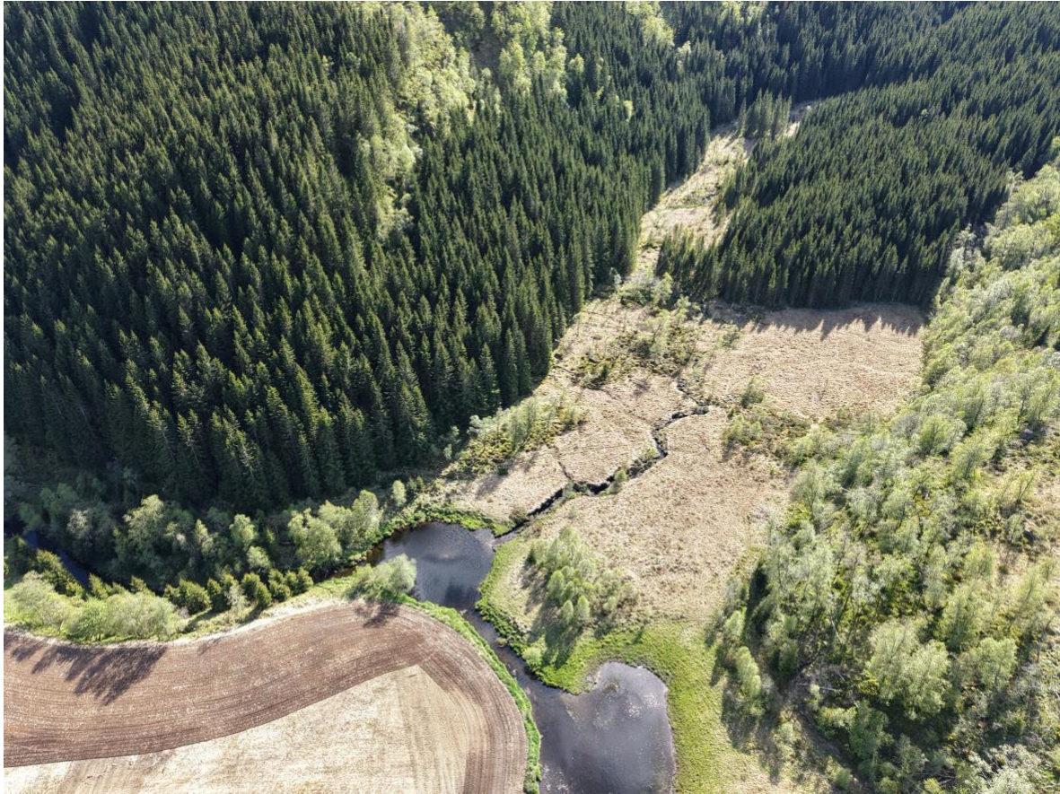
Bilde 5: Vannstekning oppstrøms Dalelva kraftverk
