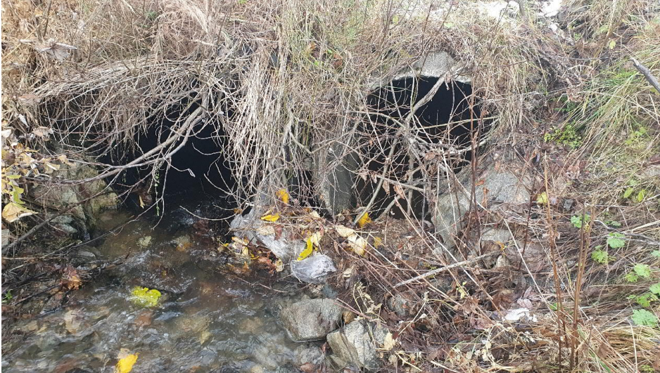
Figur 5-3. Innløp til kulverter under H.M. Holsts vei, sett i vannets retning.
