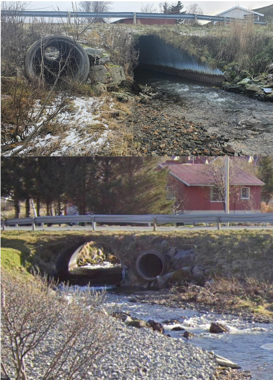
Figur 4-8. Eksisterende bru for Vannvågelva under Ny-Fugløyvegen (fylkesveg 350) og et flomløp høyere i terrenget i form av en Ø1400 mm betongkulvert. Øverste bilde: sett fra oppstrøms side, nederste bilde: sett fra nedstrøms side.
