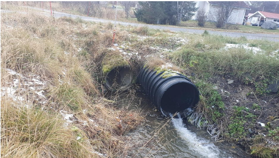
Figur 5-4. Utløp fra kulverter under H.M. Holsts vei, sett i oppstrøms retning.
