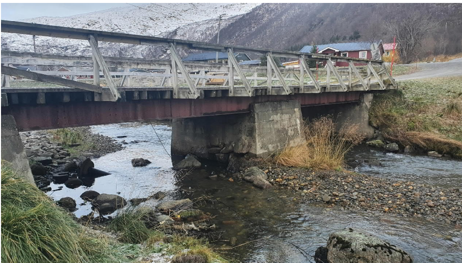
Figur 4-9. Bru over Vannvågelva på Gammelvegen, sett i oppstrøms retning.
