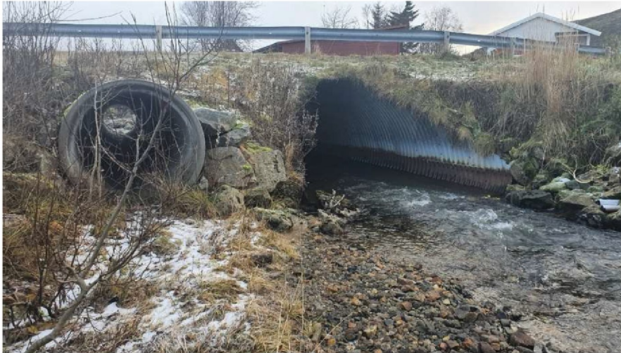
Figur B. Hovedbru fra oppstrøms side. Brunfarge viser jevnlig vannstandnivå.
