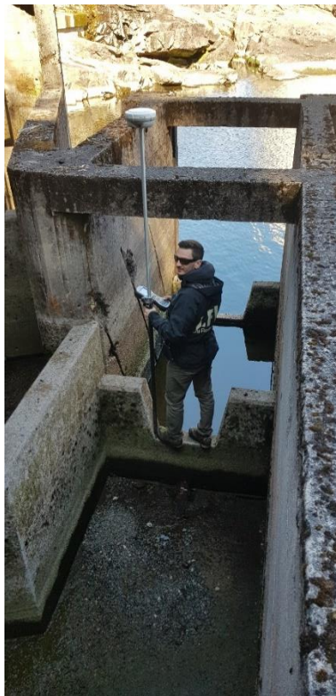
Figur 19. Fisketrapp i Skotfoss (øverst) (foto Stranzl 2020), med særlig høy energitetthet i de to første kulpene (nederst).
