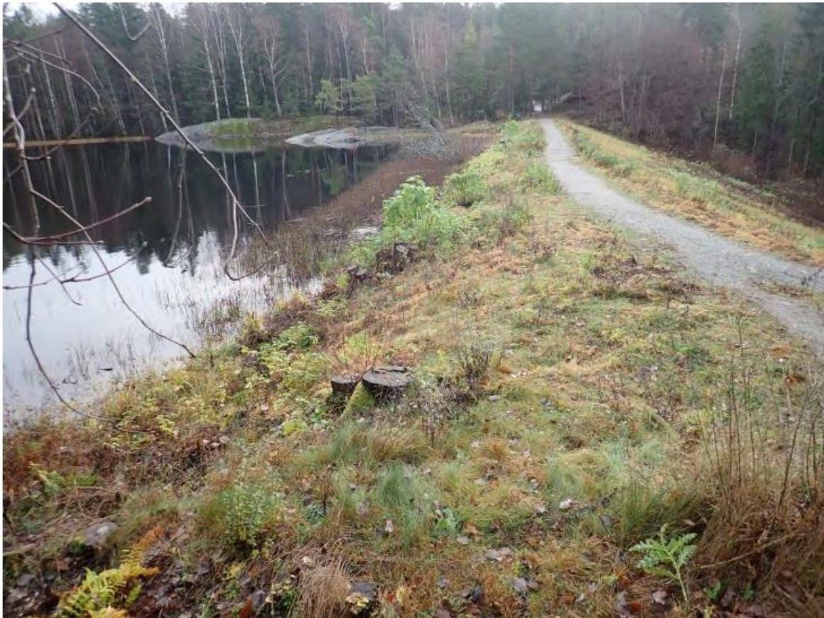
Bilde 1. Hoveddammen. Oppstrøms side og damkrone sett fra høyre (vestre) landfeste (Foto: Civil Consulting)
