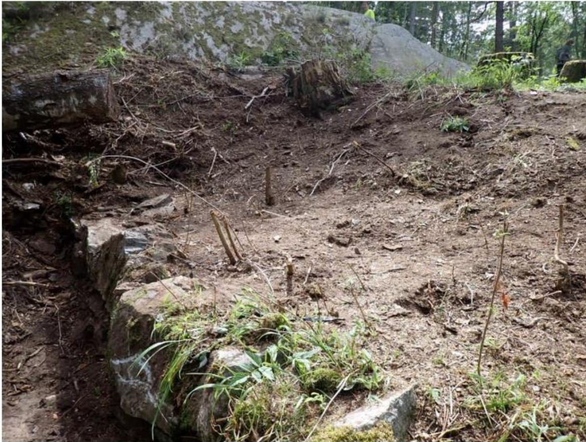
Bilde 3. Sperredam 1 med avslutning av steinblokker i nedstrøms skråning (Foto: Civil Consulting)
