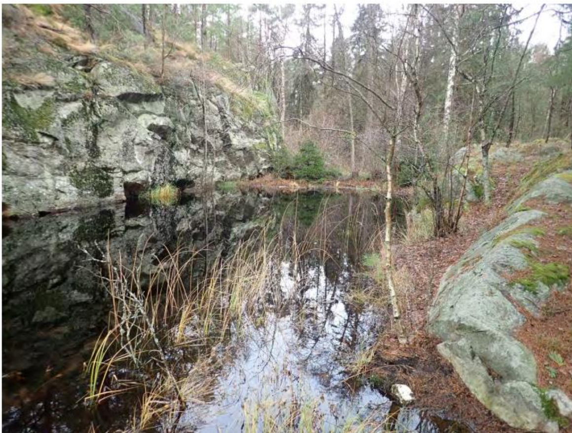
Bilde 2. Sperredam 1. Oppstrøms side sett fra magasinet (Foto: Civil Consulting)
