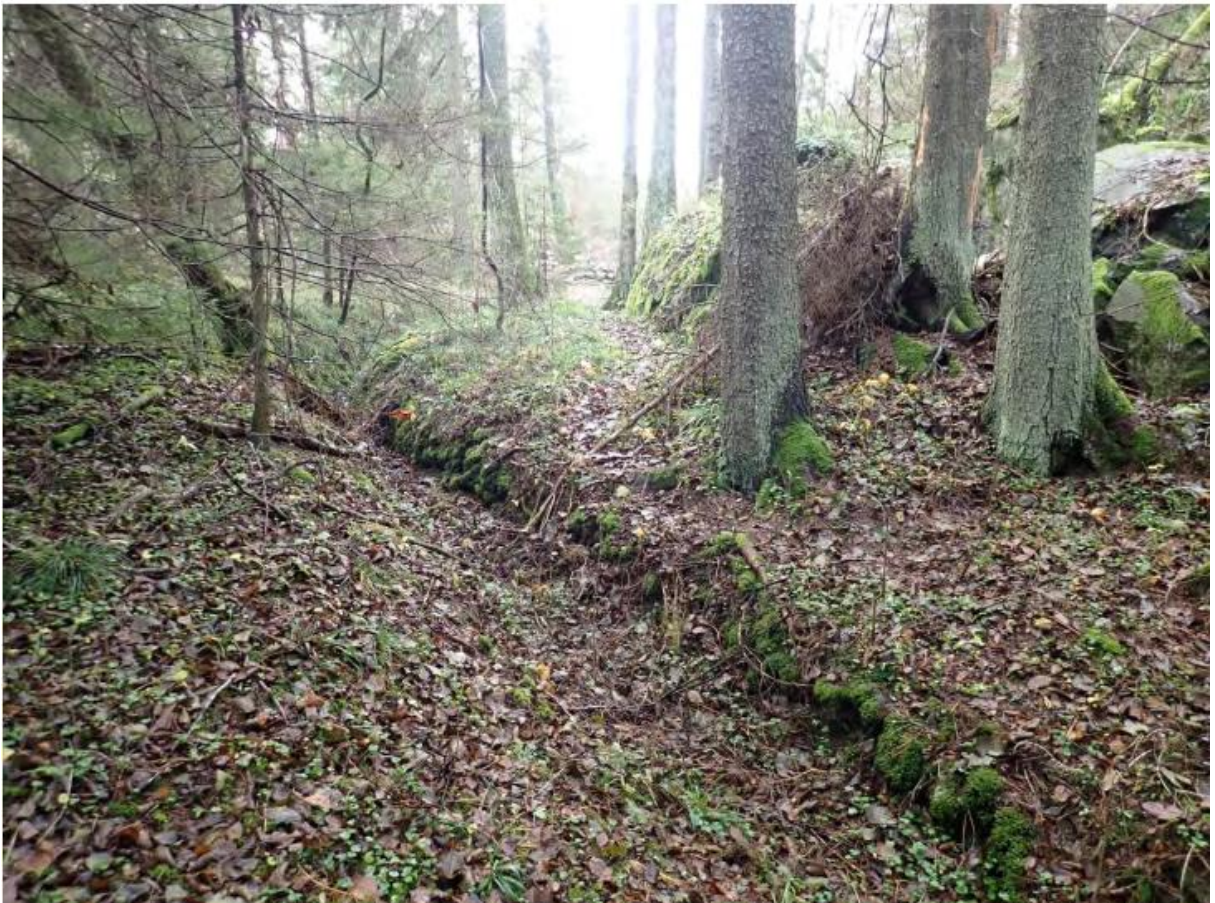
Bilde 6. Sperredam 1, tidligere flomløp sett fra dammen (Foto: Civil Consulting)
