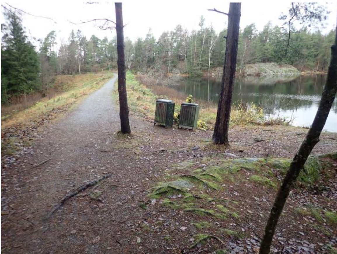
Bilde 4. Hoveddammen sett fra venstre (østre) landfeste (Foto: Civil Consulting)
