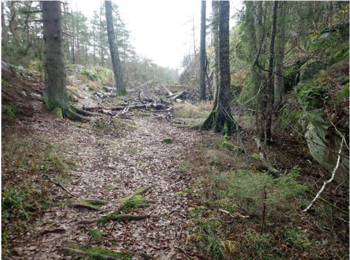
Bilde 5. Sperredam 1, sett fra nedstrøms side (Foto: Civil Consulting)
