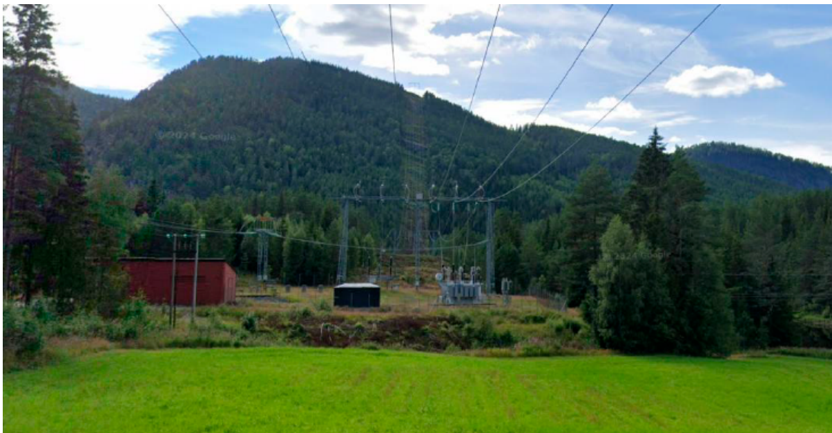
Figur 3: Dagens Einangsmoen transformatorstasjon, sett fra øst mot vest.
