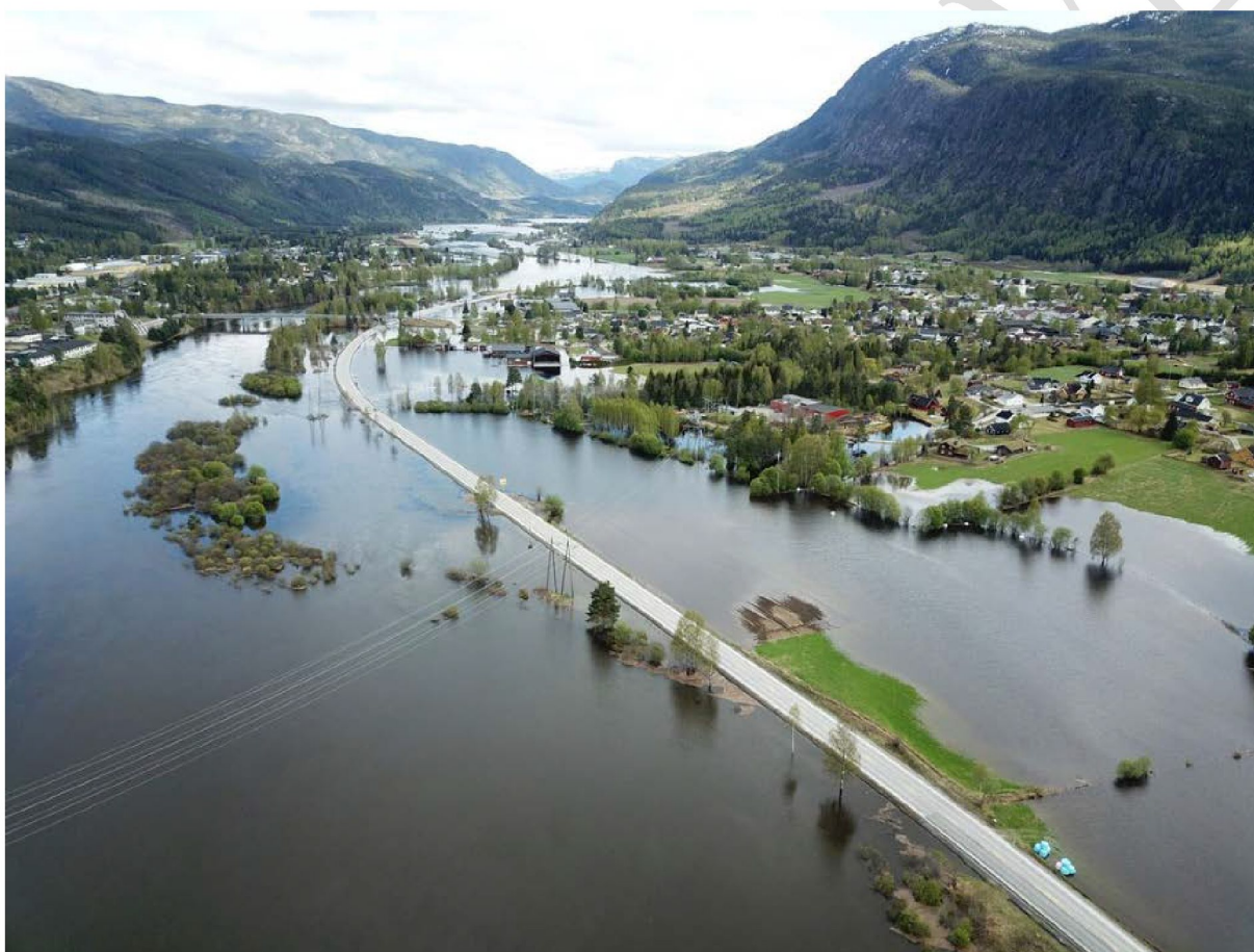
Dronebilde flom i Nesbyen i Hallingdal fra 2018. Foto: NVE
