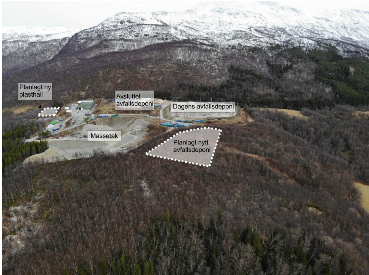
Dronefoto som viser anleggsområde på Galsomelen. Anleggsområde består blant annet av massetak og avfallsdeponier. Planlagt areal for nytt avfallsdeponi og ny plasthall (tiltaksområder) er også skissert inn. Foto: Arktisk Geotek AS.
