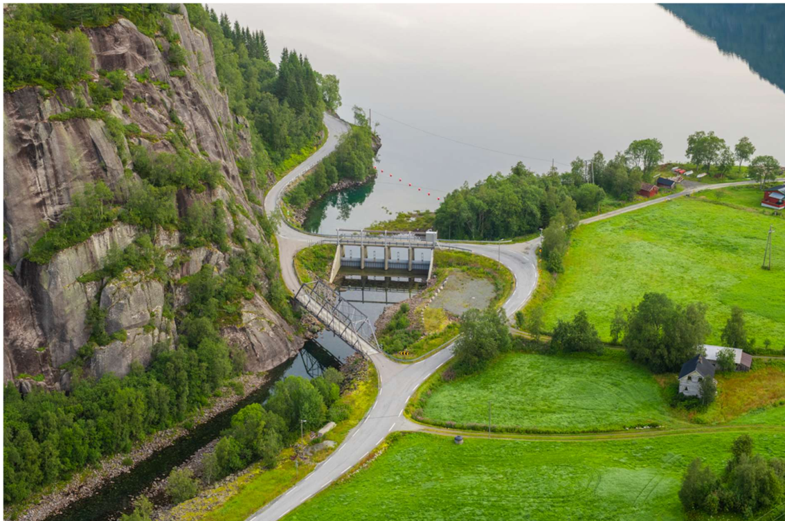
Bilde viser utløp Røldalsvatn i Botnen med dagens anlegg som er under revurdering iht damforskriftens bestemmelser.
