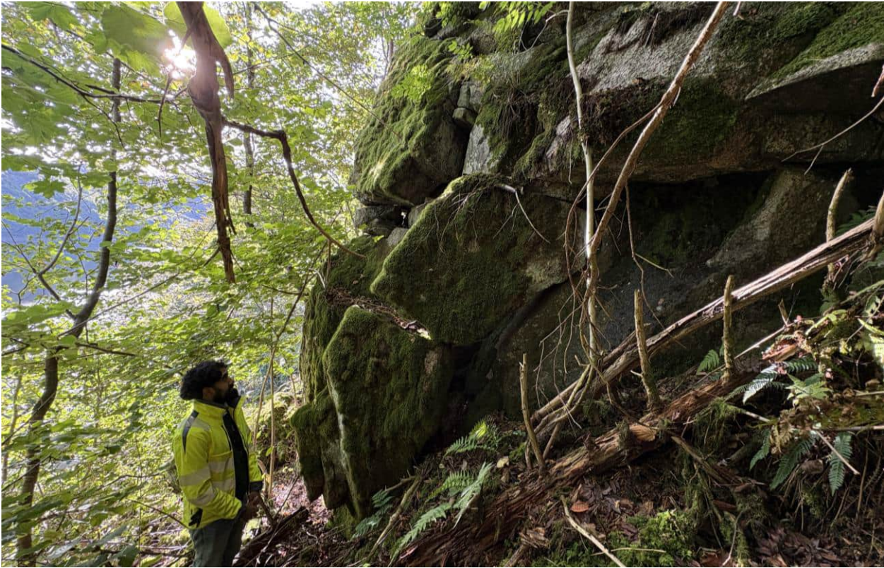
Bilde 13: Avløste blokker i størrelsesorden 1-4 m 3 . Sett mot sør. Infopunkt 7 i Vedlegg 4.
