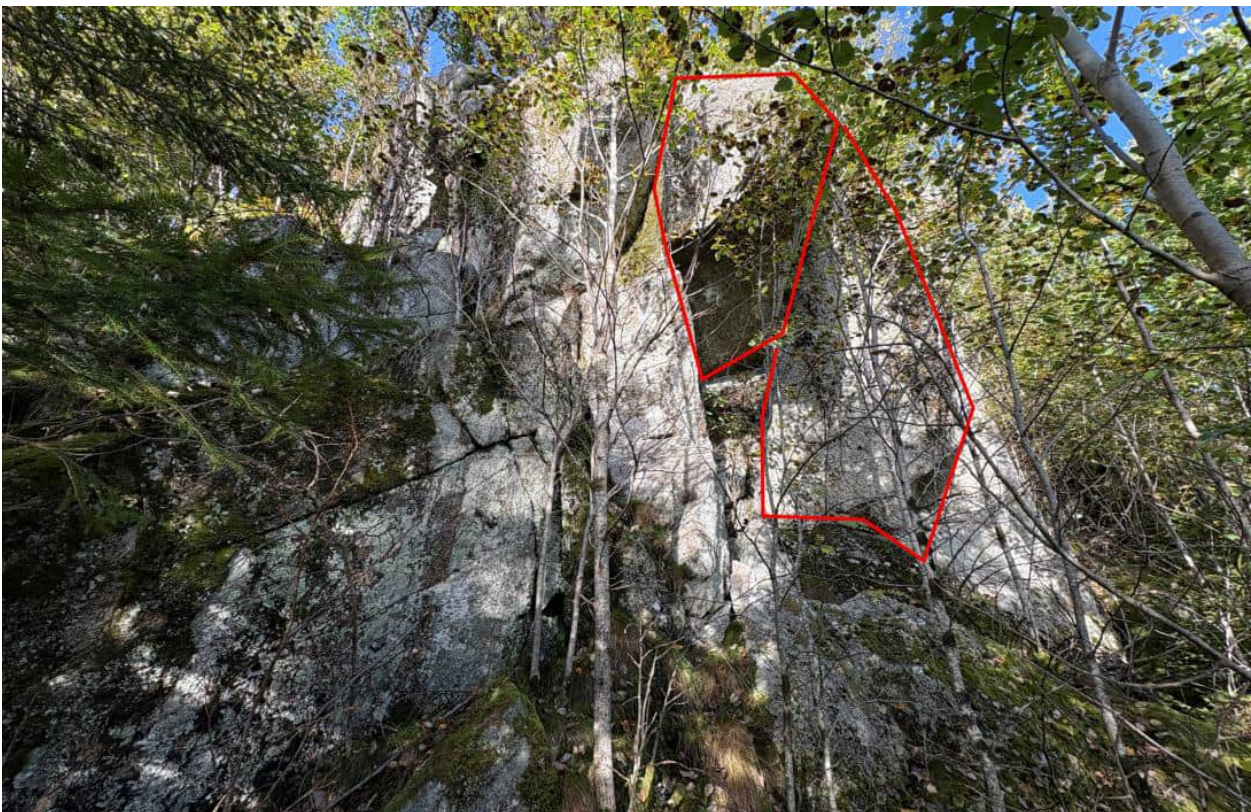
Bilde 12: Store tilsynelatende avløste blokker, samme som i Bilde 11. Sett mot nord. Infopunkt 6 i Vedlegg 4.
