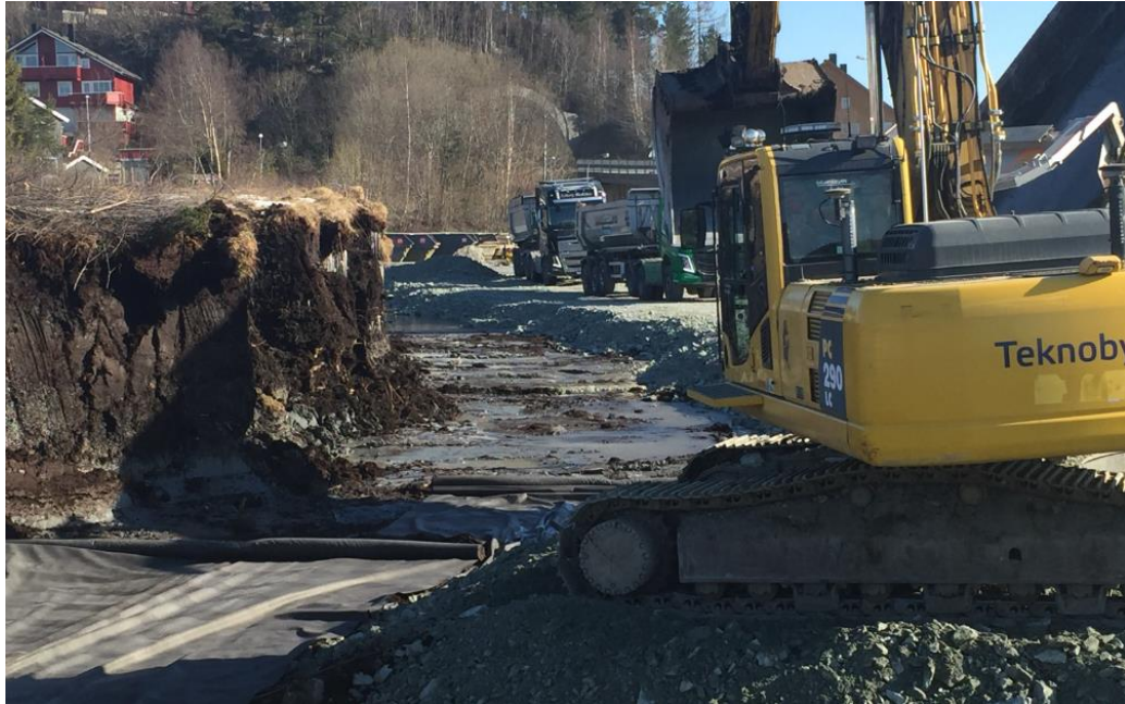
Figur 1 Foto fra masseutskifting oversendt fra Teknobygg. På bildet sees overgang mellom organisk materiale og leire, og det ser ut til at det er lagt geotekstil mellom stedlige og tilførte masser.
