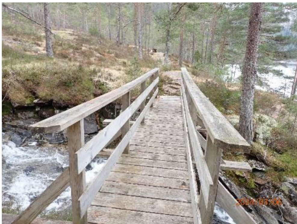
Kraftstasjonsområdet begynner 10 - 15 m rett frem etter brua
