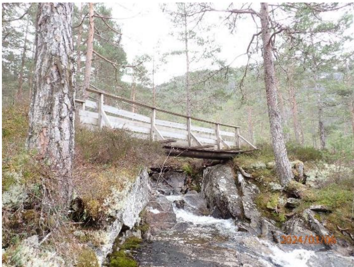
Eksisterende gangbro rett nord for kraftstasjonsområdet
