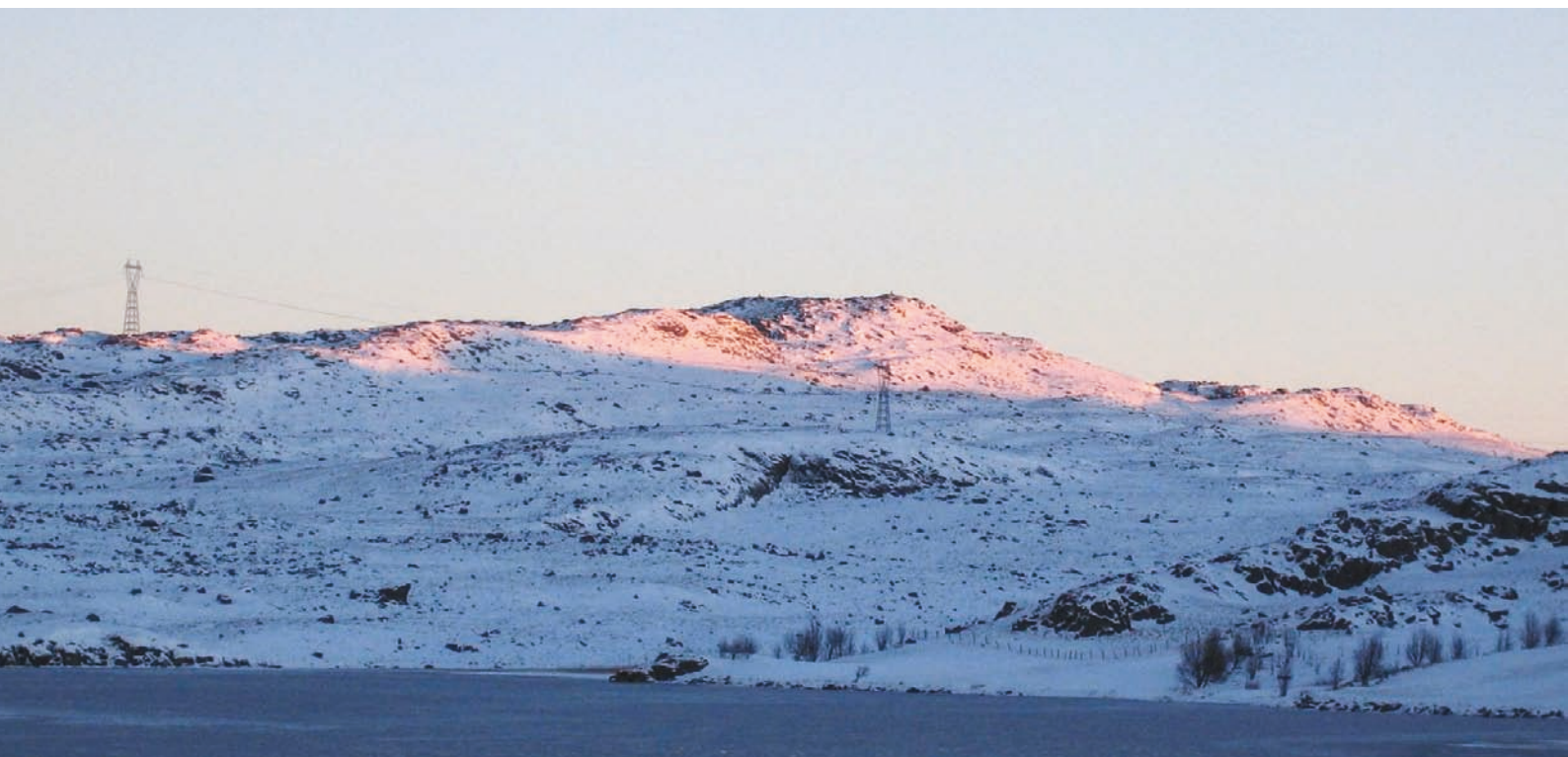
Ulvarudla i morgensol. Lyse Nett sin 300 kV ledning vises i bildet.
