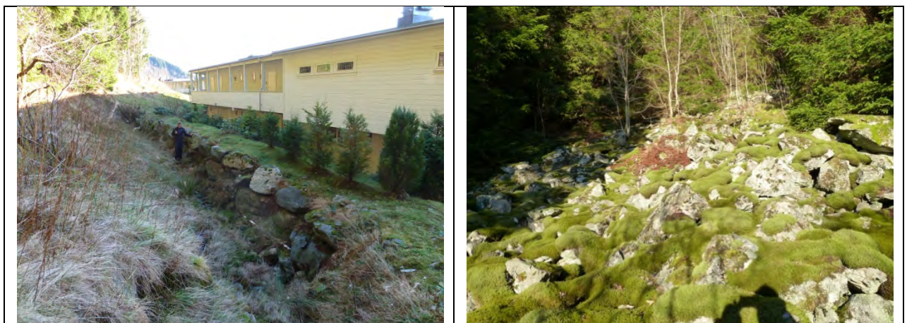
Figur 5 Bilde til venstre viser skredvoll bak bebyggelse i Solvalla terrasse. Skredvullen har høyde ca. 1,50 m og har lengde ca 30 m. Bilde til høyre viser urmasser som ligger ovenfor skredvullen. Urmassene er begrodd med mose og er trolig av eldre dato.
