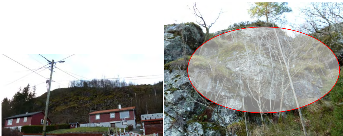
Figur 14 Bildet til venstre viser Vallahøgda 17 og 19 med skråning bak. Bildet til høyre viser oppsprekking bak bebyggelse. Markert med rødt er kileformet oppsprekking.
