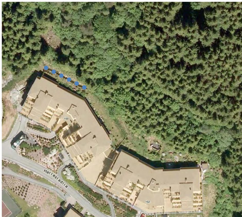
Figur 3 Oversiktsbilde over Hatlestadlia med Solvalla terrasse. Skredvullen mellom bebyggelse og skråning er markert med blå sirkler i bildet (Kilde: 1881.no).
