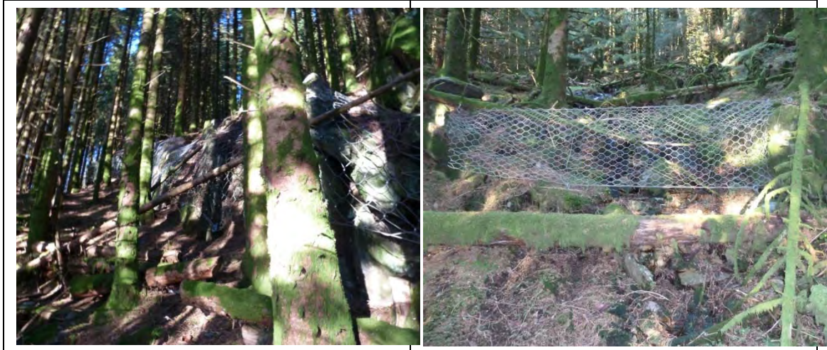
Figur 4 Eksisterende sikring ovenfor bebyggelse øverst i Hatlestadlia, Solvalla terrasse. Bildet til venstre viser sikring av oppsprukket fjellskjæring. Skjæringen er sikret med bolter og nett. Bildet til høyre viser sikring med nett utført over lavbrekk i terrenget. Vandreringsspor i søkket tyder på at nettet skal hindre eventuelle flomskred.
