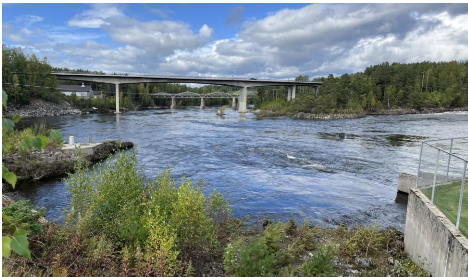
Fig 9. Foto 19.09.23. Nedstrøms Geithus kraftstasjon. Vannstand Gravfoss på LRV, vannføring 340m 3 /s. Sammenligning av vannstanden med den som vises pi figur 1 med normalvannstand er liten.
