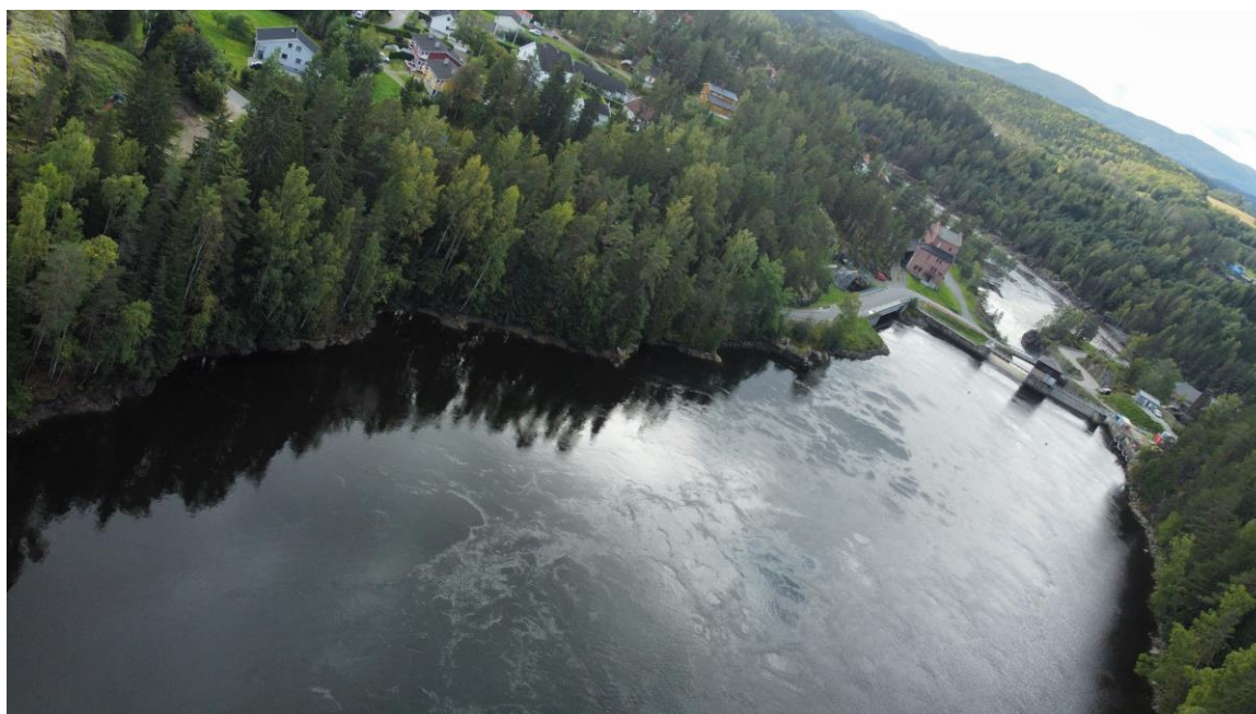
Fig 11. Strekingen ned mot Gravfosdammen har bratte strender. Elva virker dyp i dette området.
