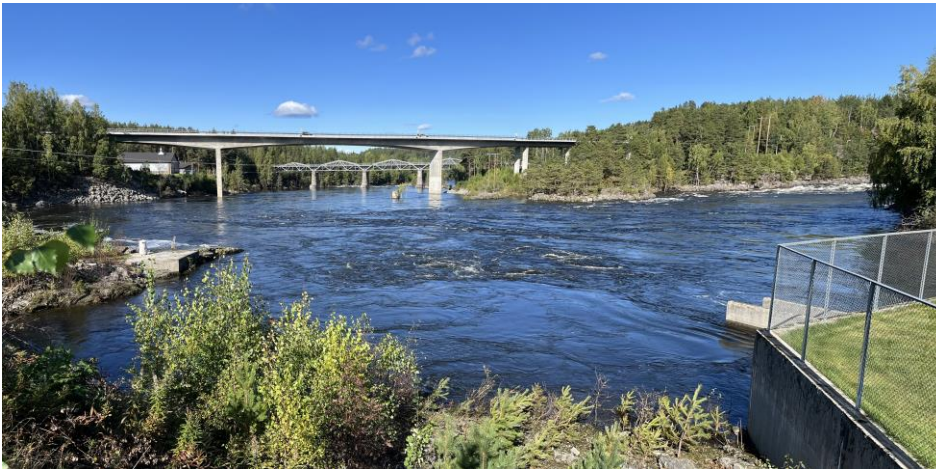
Fig 1.Drammenselva sett fra Kraftstasjonen mot bilbru og jernbanebru som begge ligger rett oppstrøms Katfoss.
