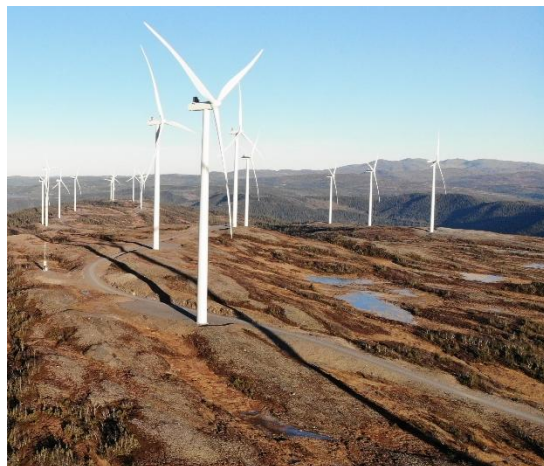
Bilde 3: Internveier etter bygging. Foto: Aneo
