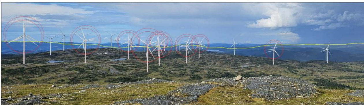
Bilde 7: Viser turbiner med 150 m rotor og navh. 120 m (alt B) mot 136 m rotor og 112 m navh. (alt A)
