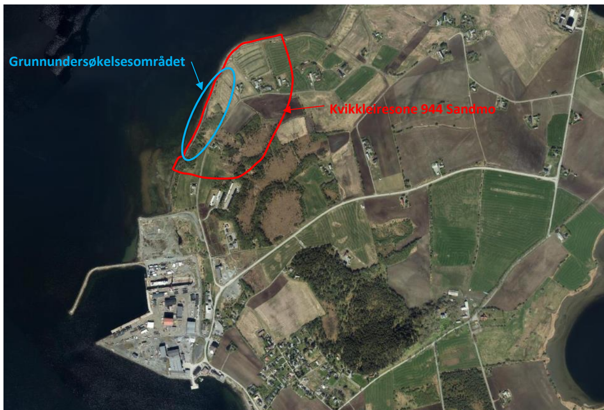
Figur 3-2: Flyfoto. Kvikkleiresone 944 er markert med rødt og grunnundersøkelse området er markert med blått. Kilde: https://kart.finn.no og https://geo.ngu.no/kart/
