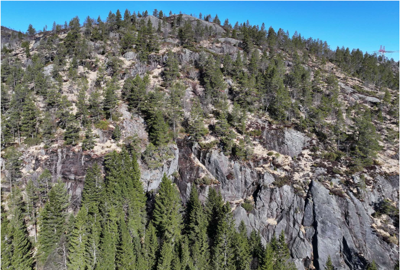
FOTO 6: Dronefoto av lausneområdet for snøskred. Bergskrenten ved om lag kote 515 vist i nedre del av foto.
