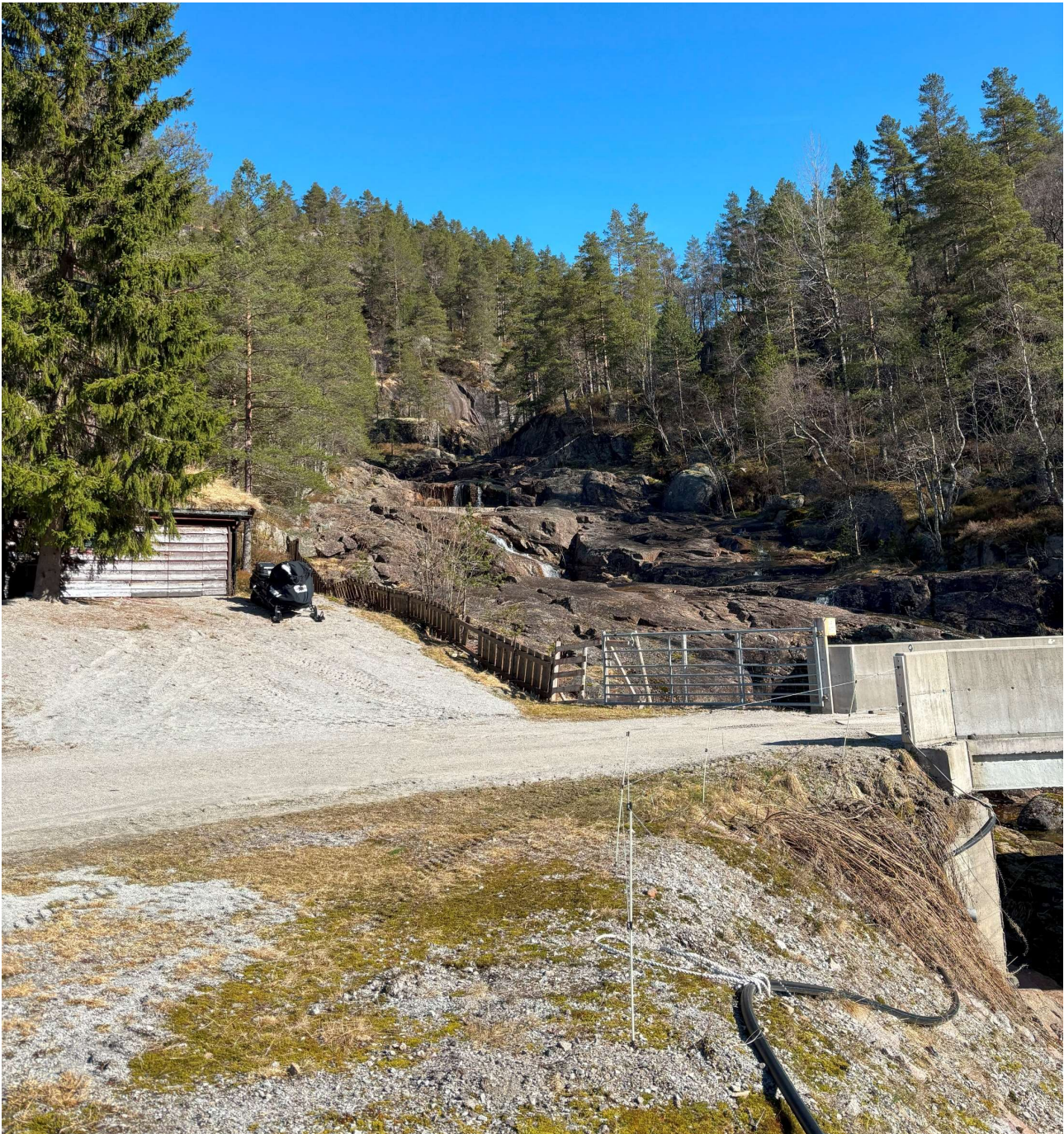
FOTO 1: Ved brua – elveløp med synleg bart berg
