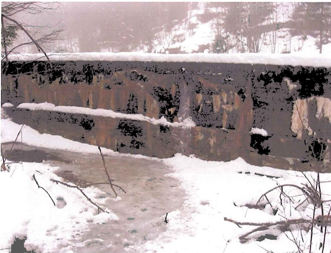
Midtre Askdam, desember 2009. Typisk sprekke-mønster med kalkutfelling.
