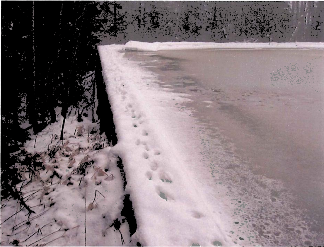
Midtre Askdam, desember 2009. Dypål og lavbrekk ved overløp.
