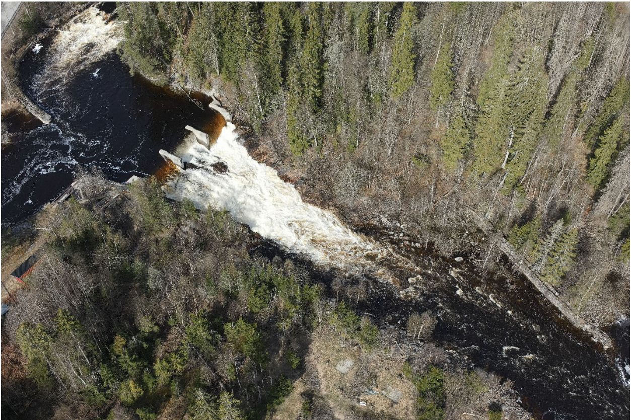
Heiernfossen, oppstrøms fra elvebendet med erosjon
