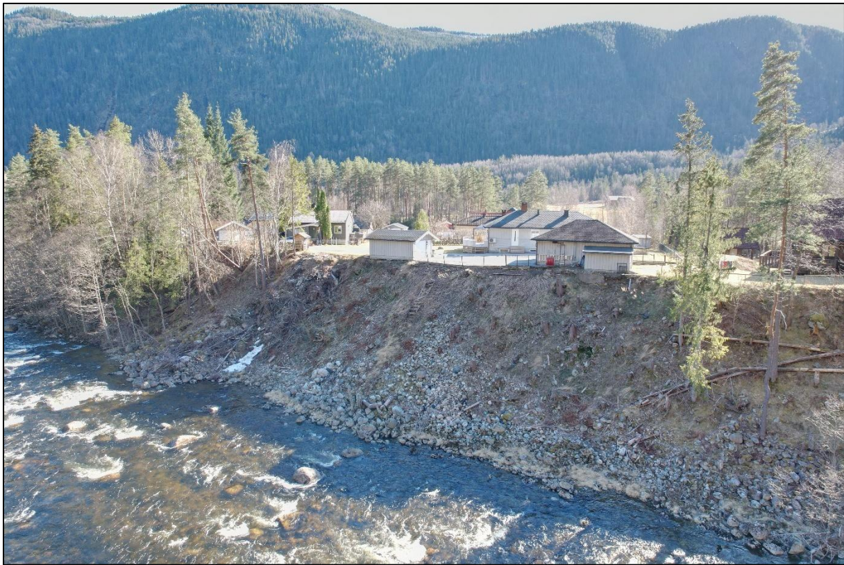
Figur 12: Elveskråning hvor mindre utglidninger vurderes å kunne oppstå.
