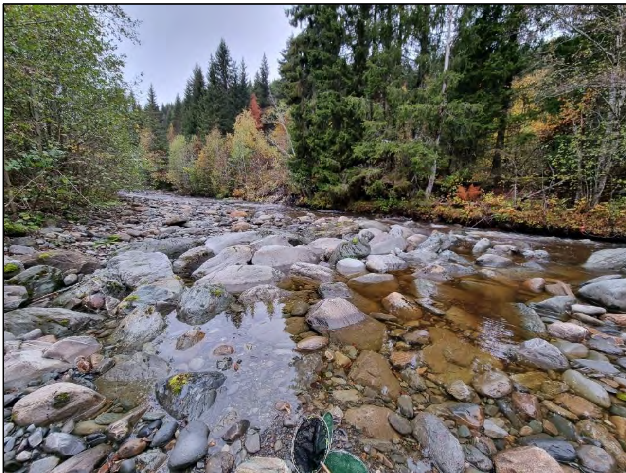
Figur 2 viser terskel T10. Terskelen er ødelagt på grunn av flom og planlegges renoveret.
