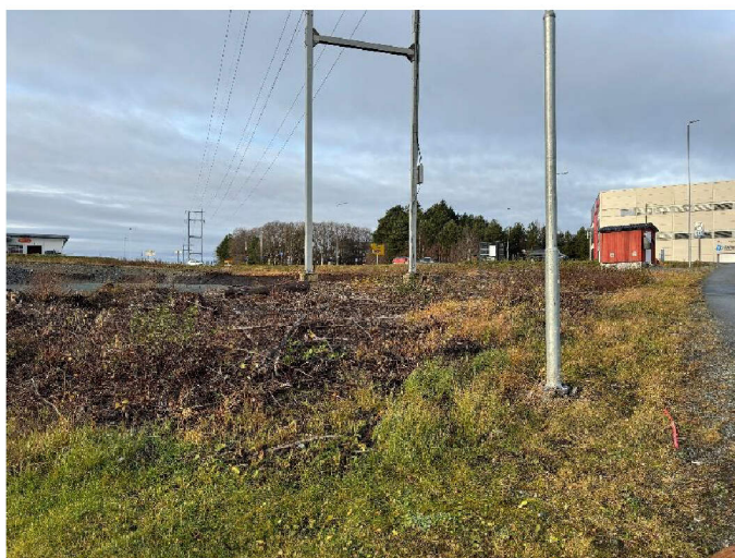
Figur 21 Området rundt eksisterende mast nr. 20 helt i vest, hvor det nylig er hugd og planert rett ved. Foto: Sweco.
