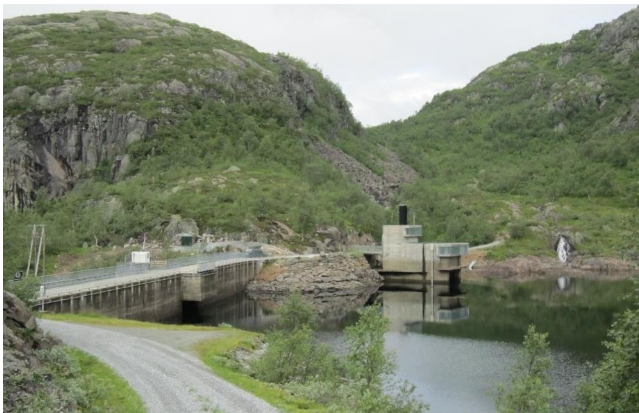
Figur 2-64 Dam Kvanndalsfoss ved kote 624 som representerer normal lavvannstand. Magasinet blir sjelden tappet ned under dette. I denne delen av magasinet er ikke reguleringssonen mest fremtredende.
