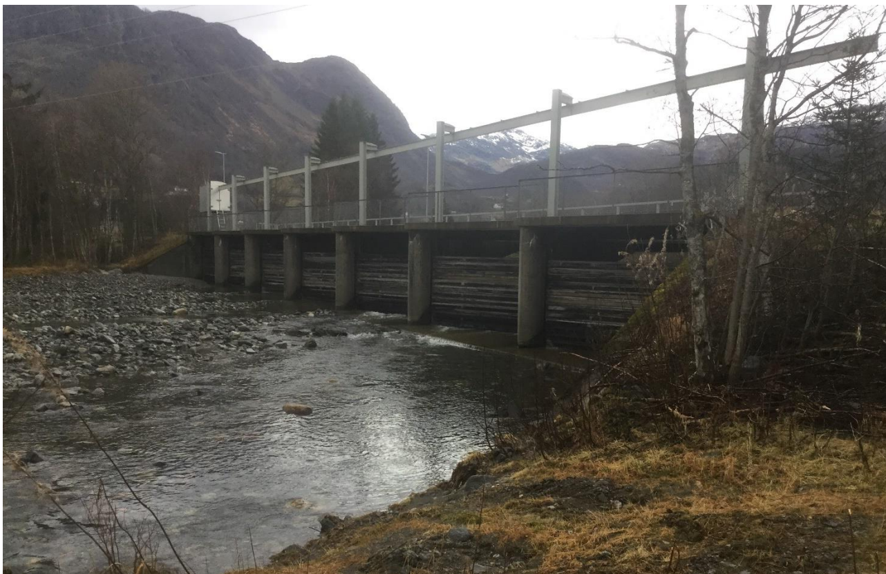
Figur 2-83 Bjelkestengsel i naturlig elveløp.
