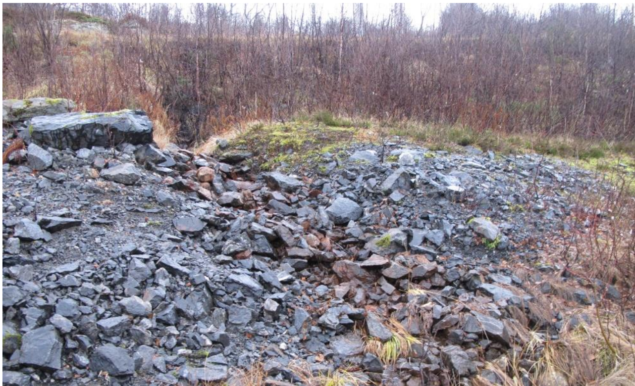
Figur 2-75 Påføring av noe mer jordmasser over sprengsteinen er enkelte steder ønskelig.
