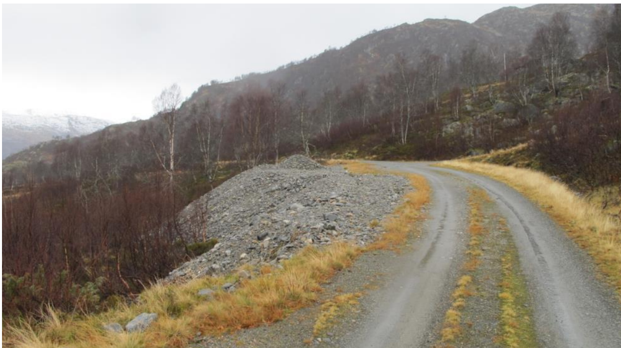
Figur 2-76 En bør terrengforme og revegetere masser som er rensket ut fra inntaksmagasin. Disse massene er lagt oppå terrenget. De vekstmassene som burde vært skavet av og lagt på toppen av massene for revegetering, ligger nå under alle grusmassene.
