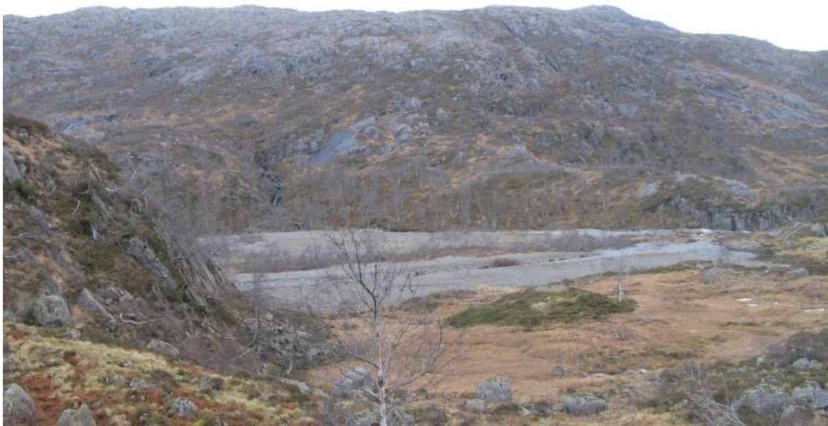
Figur 2-71 Utvaskede masser nedstrøms Vasstølvatnet ved Vadholmane
