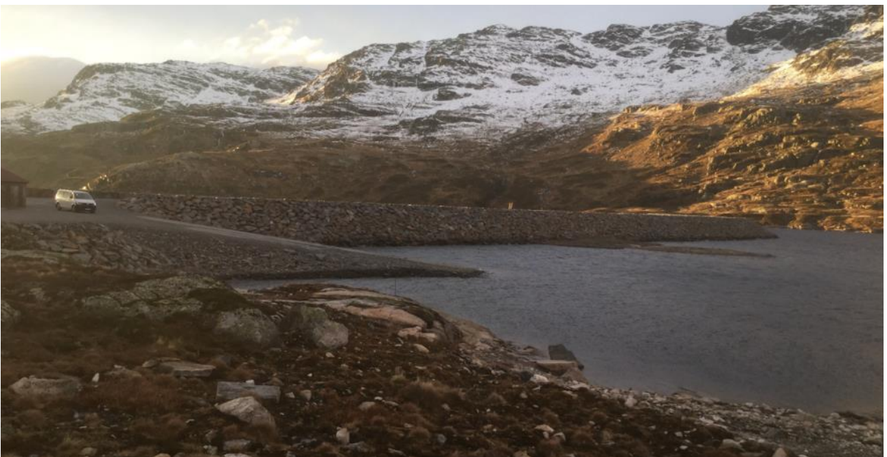
Figur 2-14 Oppstrøms side av Finnabudammen
