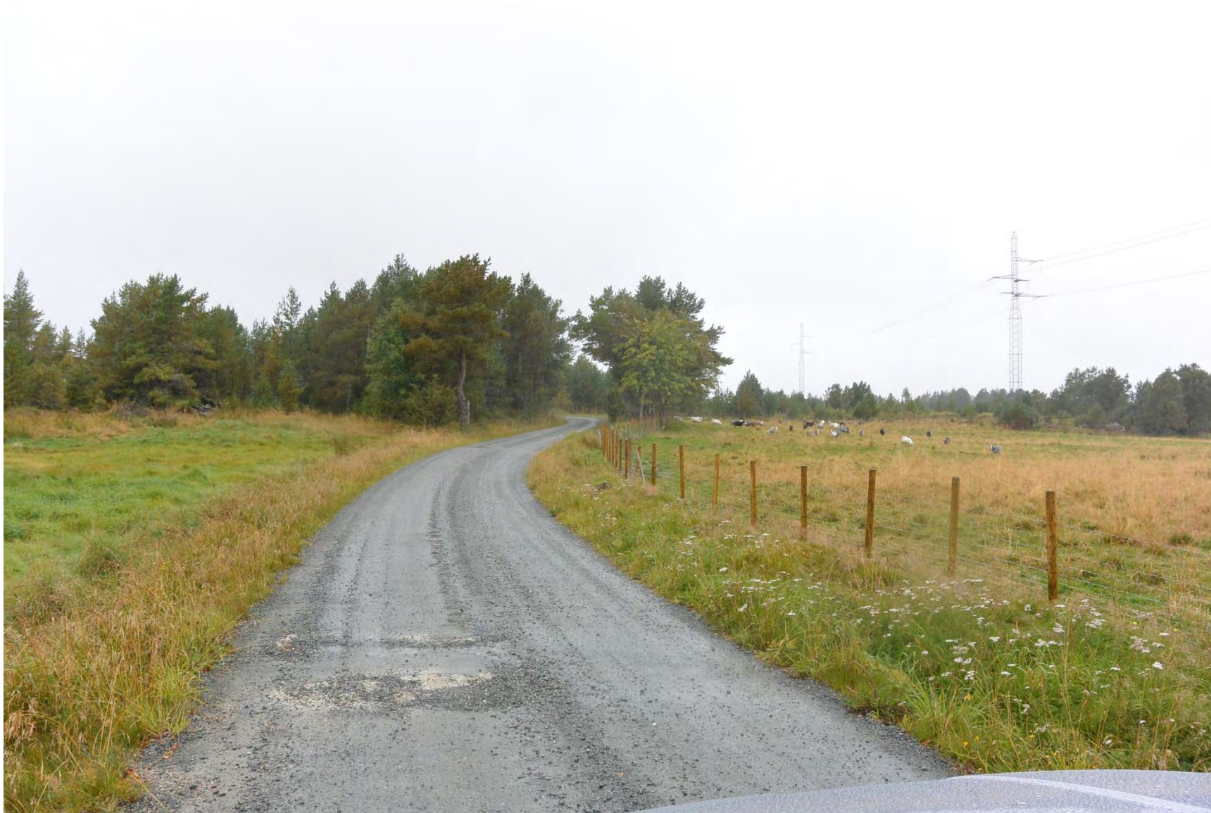
Figur 2. Sandstadveien mot trafotomta. Nærmeste mast 132 kV skal erstattes med kabelendemast for 132 kV avgreining. Trafotomta rett fram i bildet.
