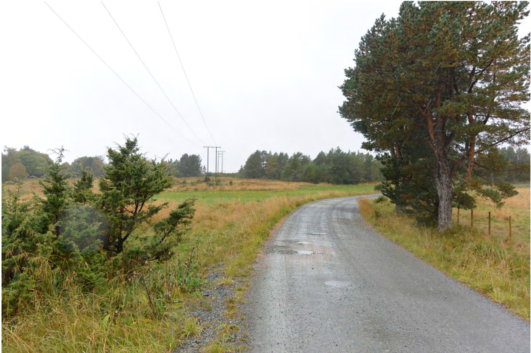
Figur 1. Sandstadveien inn mot trafotomta. 22 kV til venstre i bildet går mot vest-sørvest, rett sør for den trekledde haugen sør for trafotomta. Foto HBJ.
