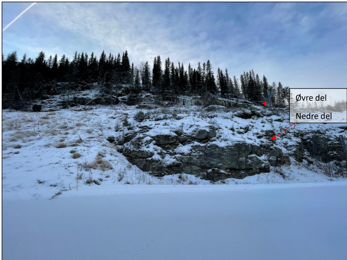
Figur 4: Nedre del av skrent har tilnærmet horisontalt sprekkesett. I øvre skrent faller sprekkesett ned mot kartleggingsområdet.
