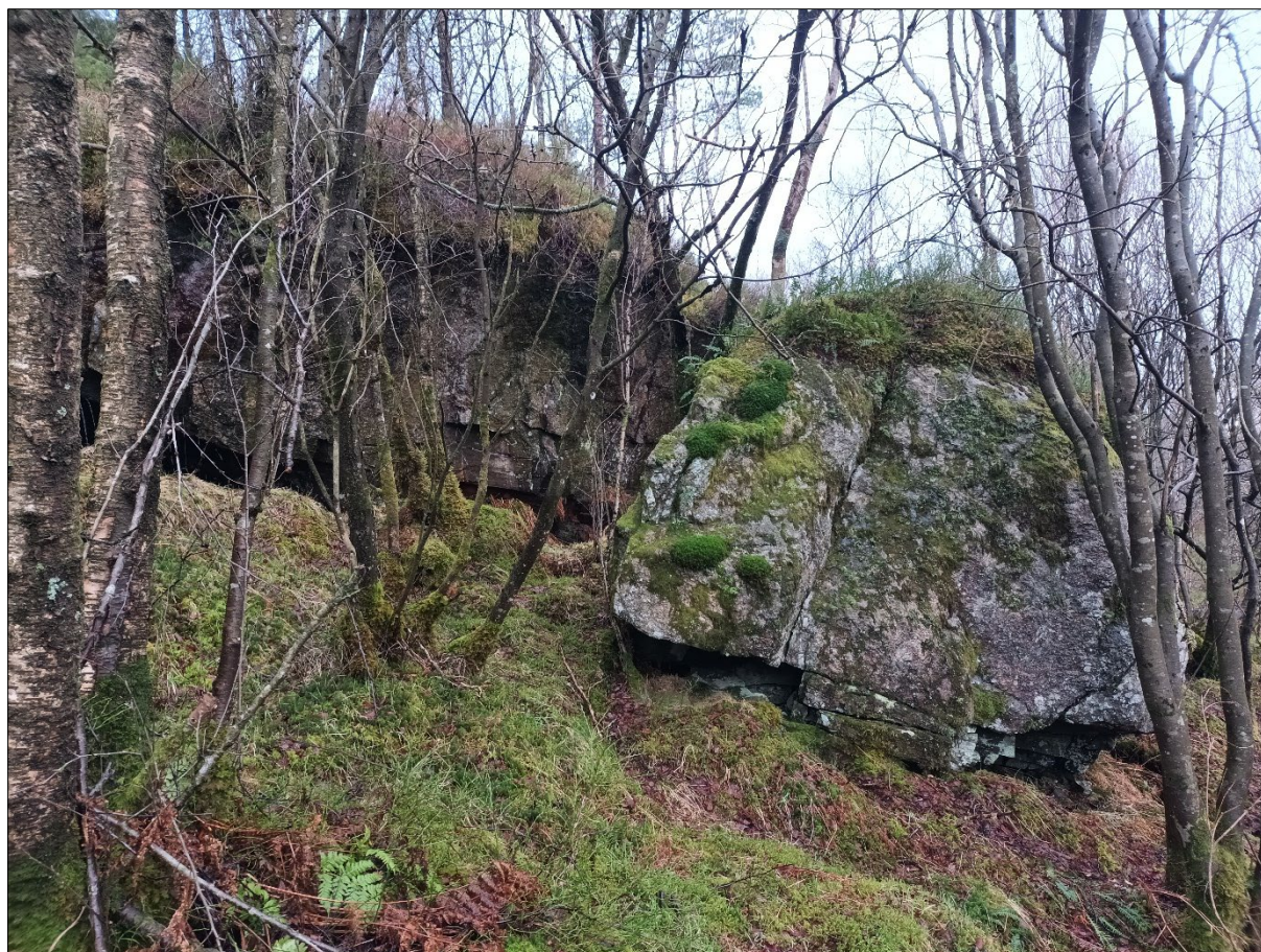
Figur 21: Bilde av berggrunn og blokk i nedre deler av påvirkningsområdet. Det er vurdert at blokken ligger stabilt i en mindre steinsprangsur omtrent 20 m sørvest for kartlagt område.
