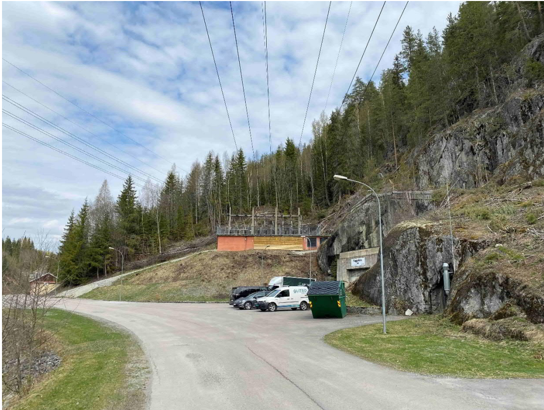
Figur 5 Inngang til Kaggefoss kraftverk langs Kaggefossveien. Areal langs veien planlegges benyttet som riggområde. Koblingsanlegg skal saneres.
