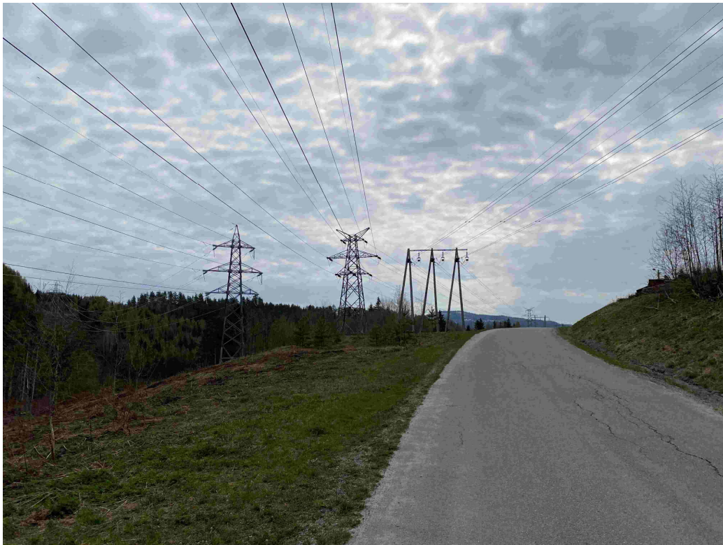
Figur 1 Eksisterende kraftledninger langs Kaggefossveien, hhv. eksisterende 132 kV (til venstre), eksisterende 50 kV Kaggefoss-Solberg/Bragernes som skal saneres (i midten) og eksisterende 50 kV Kaggefoss- Gravfoss (til høyre).
