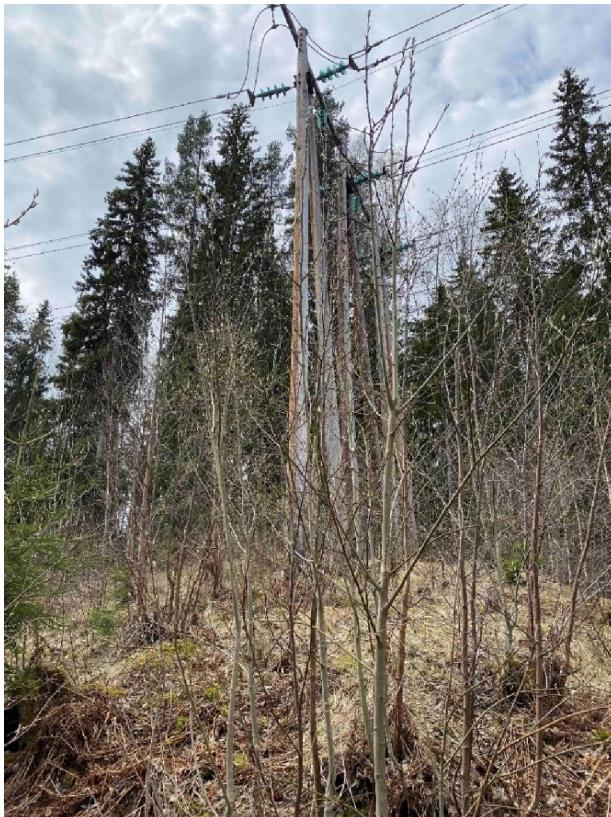
Figur 6 Eksisterende mast (50 kV Kaggefoss-Gravfoss) skal oppgraderes til kabelendemast eller saneres og erstattes med ny kabelendemast.
