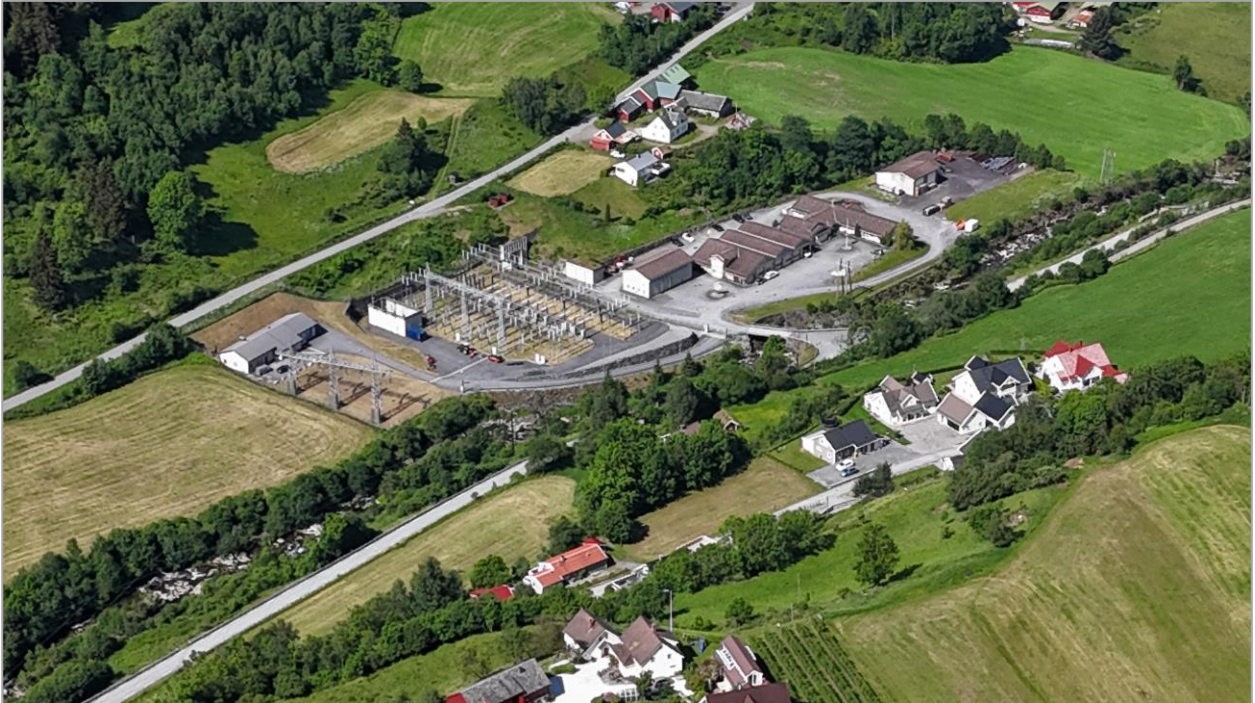
Bilde 1. Dronebilde over Hove kraftverk. Bilde er tatt mot vest.
