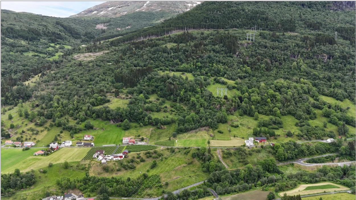
Bilde 5. Dronebilde over nedre del av dalsiden øst for kraftverket.
