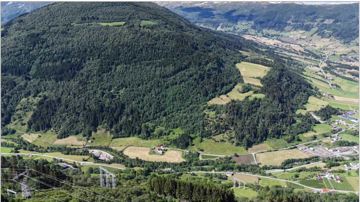
Bilde 2. Dronebilde over dalsiden sørvest for Hove kraftverk. Kraftverket ses nede i høyre bildekant.
