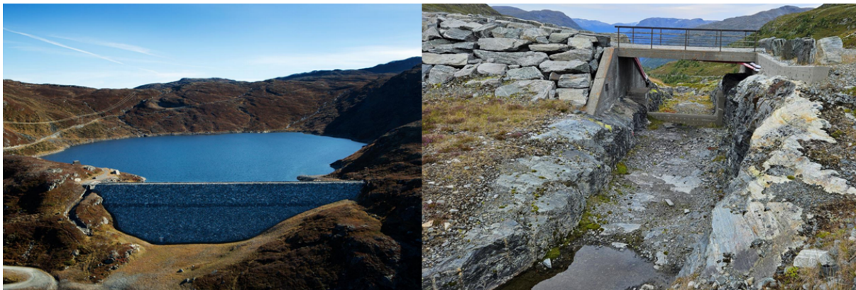
Figur 3. Til venstre vises et bilde av dam Vassetvatn fra søknaden. Eksisterende overløp ligger på dammens venstre side. (Kilde: søknaden). Til høyre vises et nærbilde av eksisterende overløp på dam Vassetvatn (fig. 3 i vedlegg 7 til søknad, Norconsultrapport)
