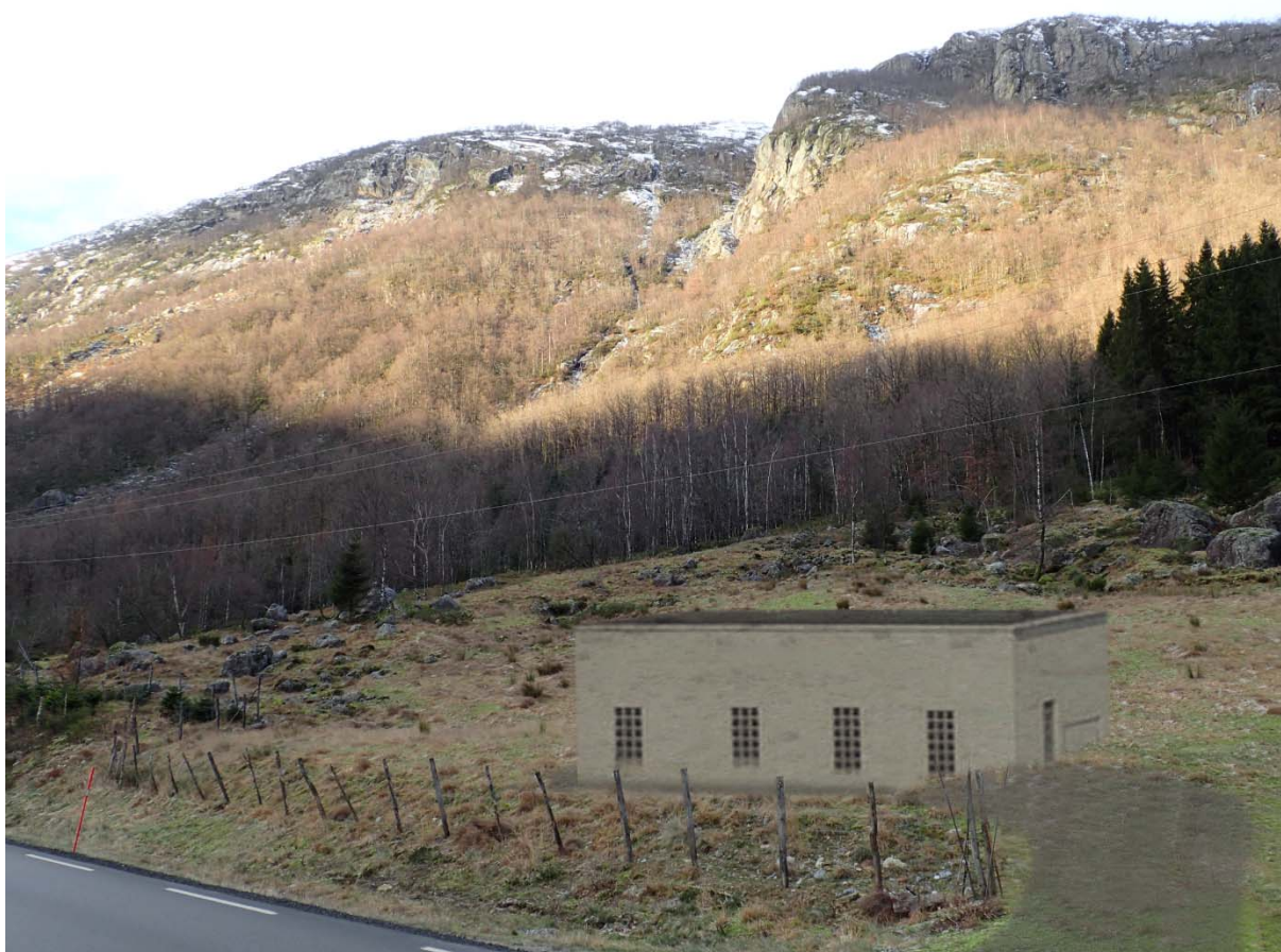
Figur 7.5 Felles kraftstasjonsbygg for Mjelkefossen og Gya kraftverk
