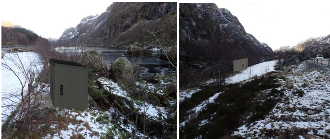
Figur 7.4 Lukehus ved inntak Gya kraftverk i Gyalona (sett motstrøms til venstre og medstrøms til høyre)
