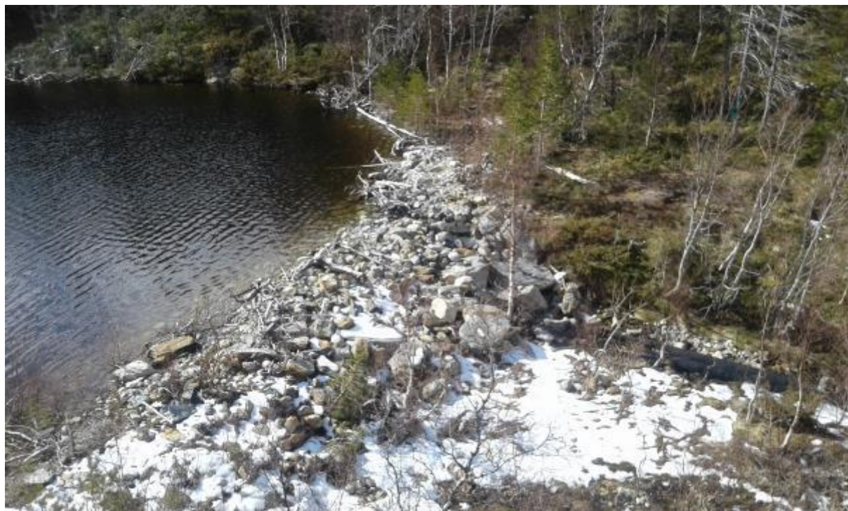
Figur 4 - Bilde som viser dammen ved Skorstadvannet. Vannrørene er synlige i høyre kant av bildet.
