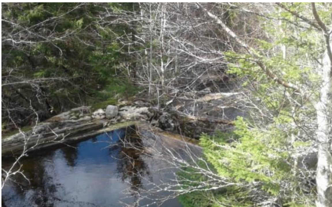
Figur 6 - Nedre dam ved nivå-tank – Kote 40
