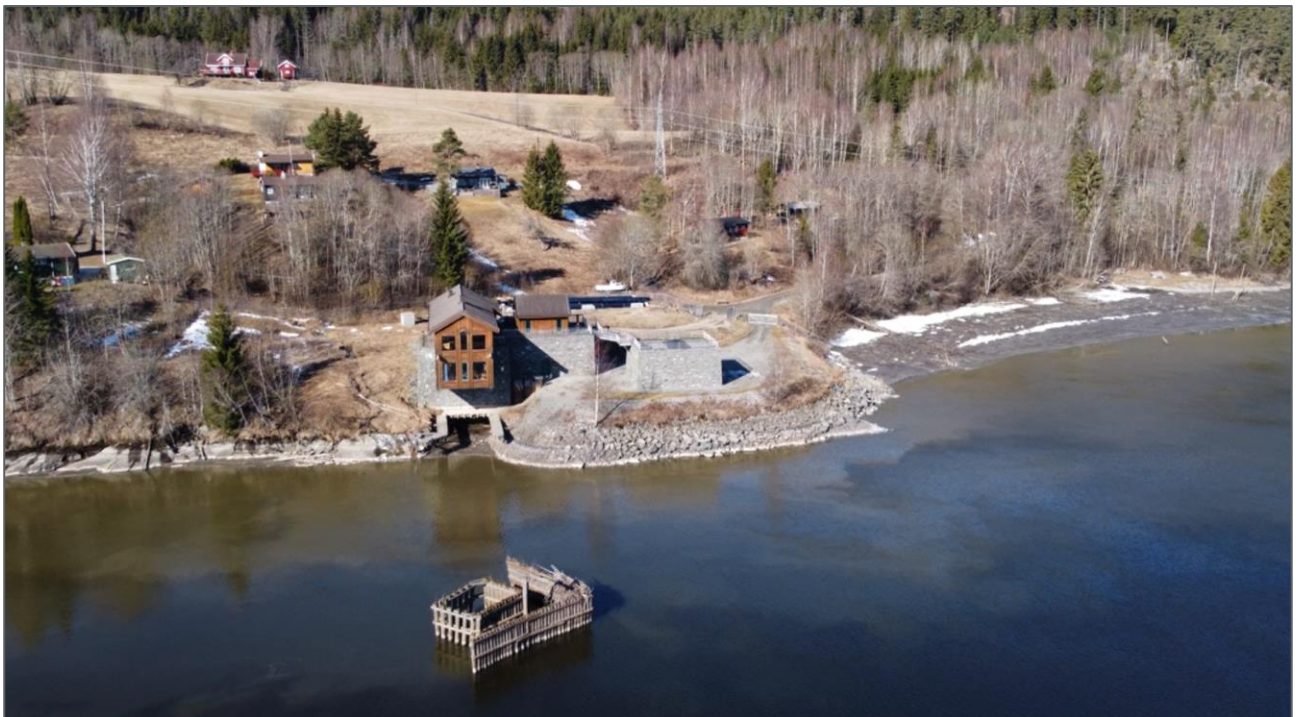
Figur 1-6: Anlegg på Hammeren. Reserveinntak er plassert ved lensen i forkant av silhuset, vist på bildet. Foto: Asplan Viak
