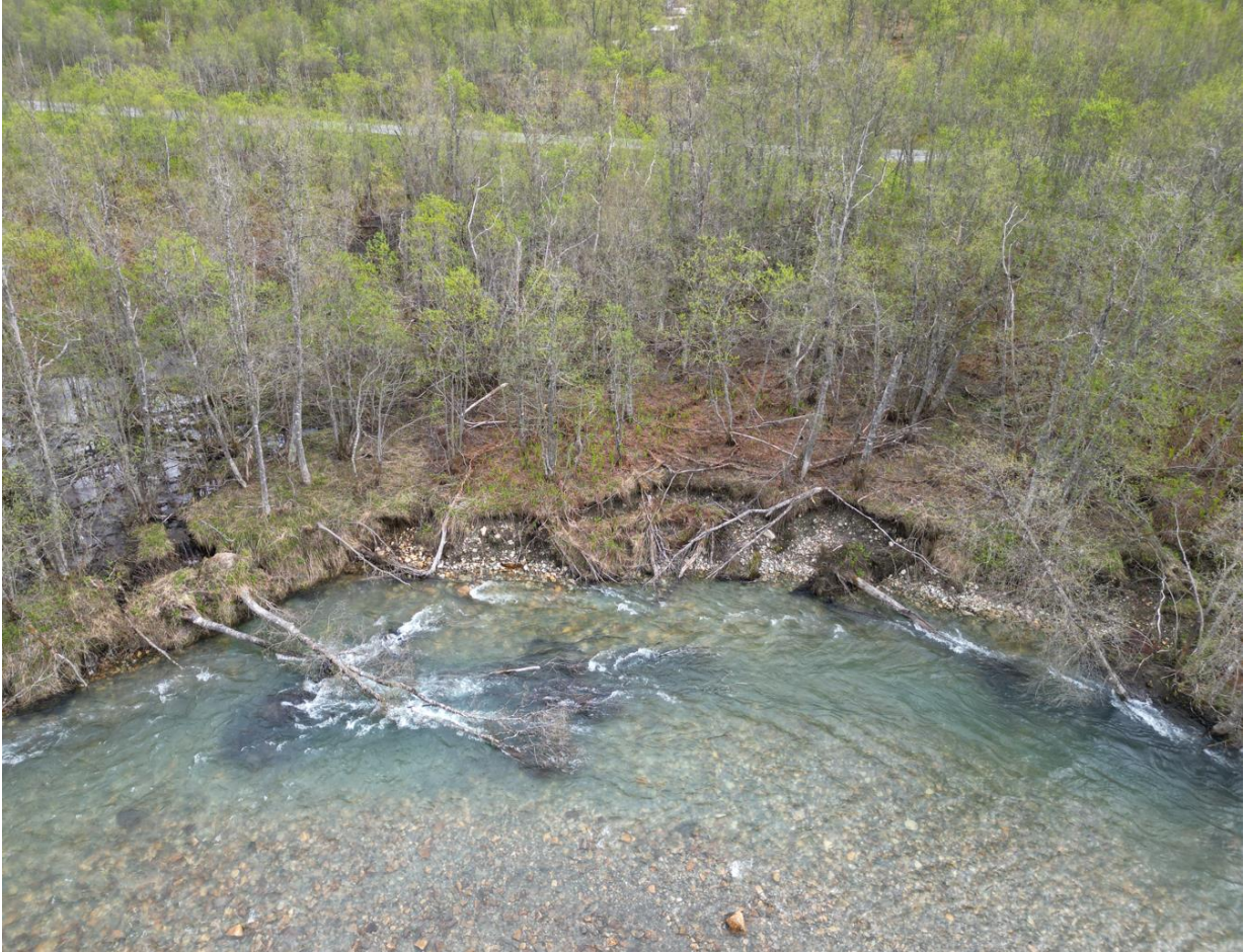
Foto 5: Erosjon i elven ved profil 1680, se tegn V06–03 (Foto: H.Lissman)
