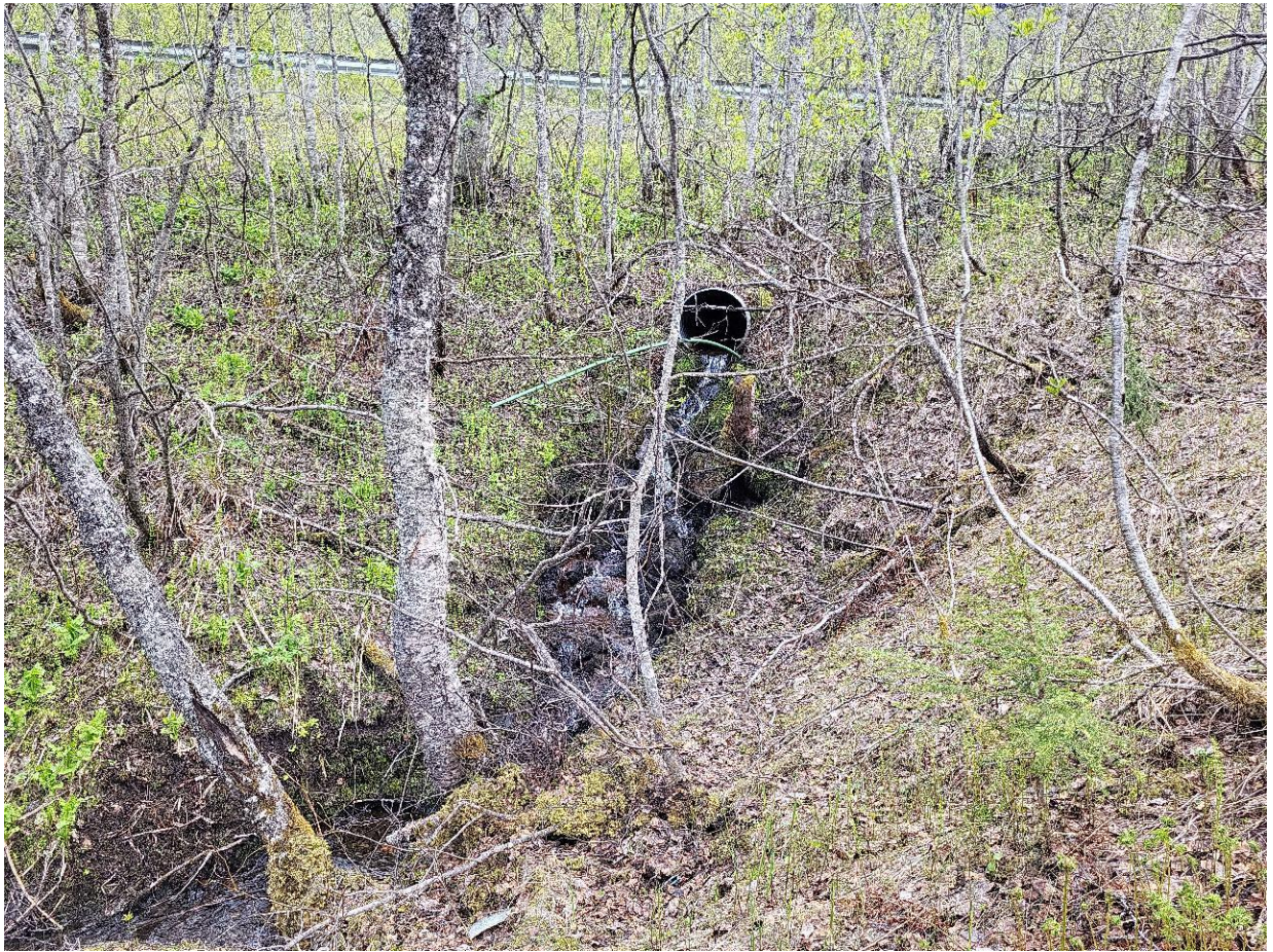
Foto 1: Utløp av dagens stikkrenne i profil 335, se tegn V06-01. (Foto: H.Lissman)
