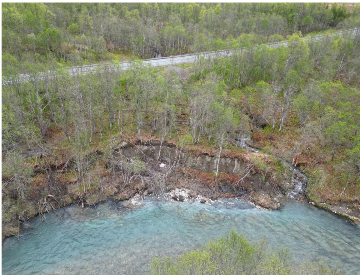
Foto 8: Erosjon i elven ved profil 1920, se tegn V06-03 (Foto: H.Lissman)
