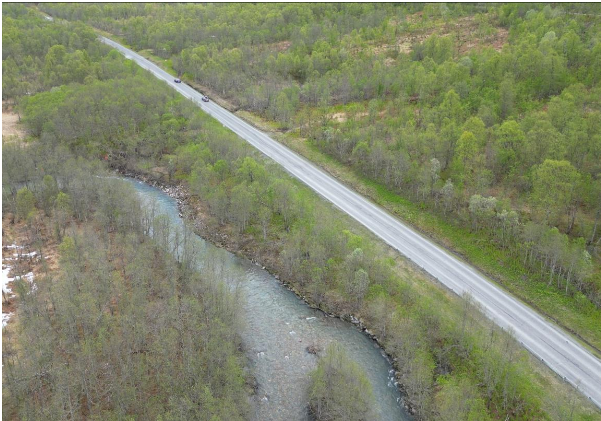
Foto 2: Utstrekning av erosjonssikring profil 1300–1450, se tegn V06–03. (Foto: H.Lissman)
