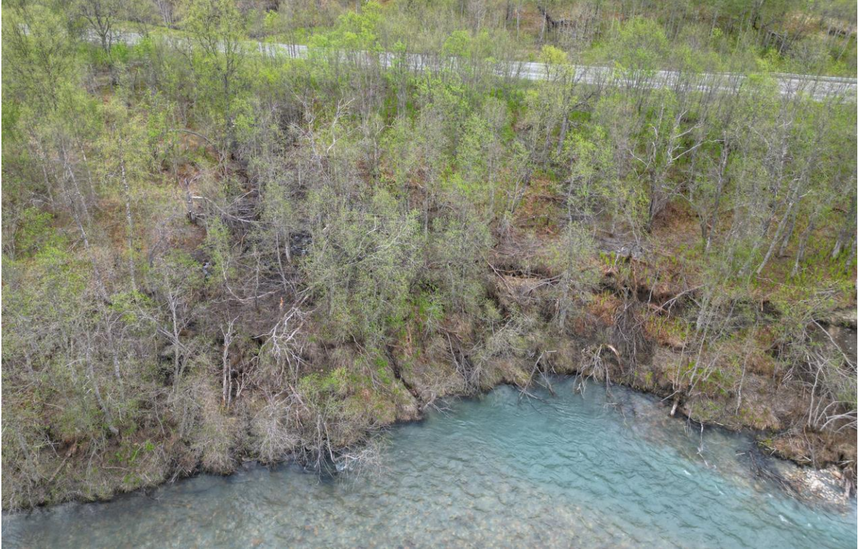
Foto 7: Erosjon i elven ved profil 1890, se tegn V06–03 (Foto: H.Lissman)
