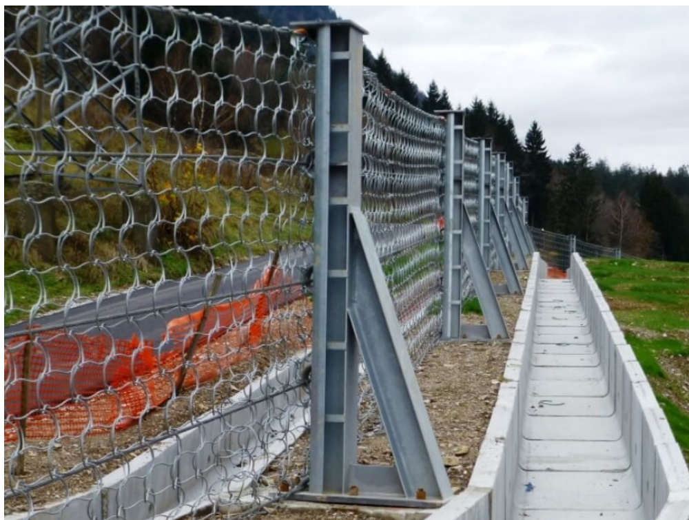
Figur 9-1 Eksempel av flomskred gjerde, her Trumer TS-DC-Delta.
