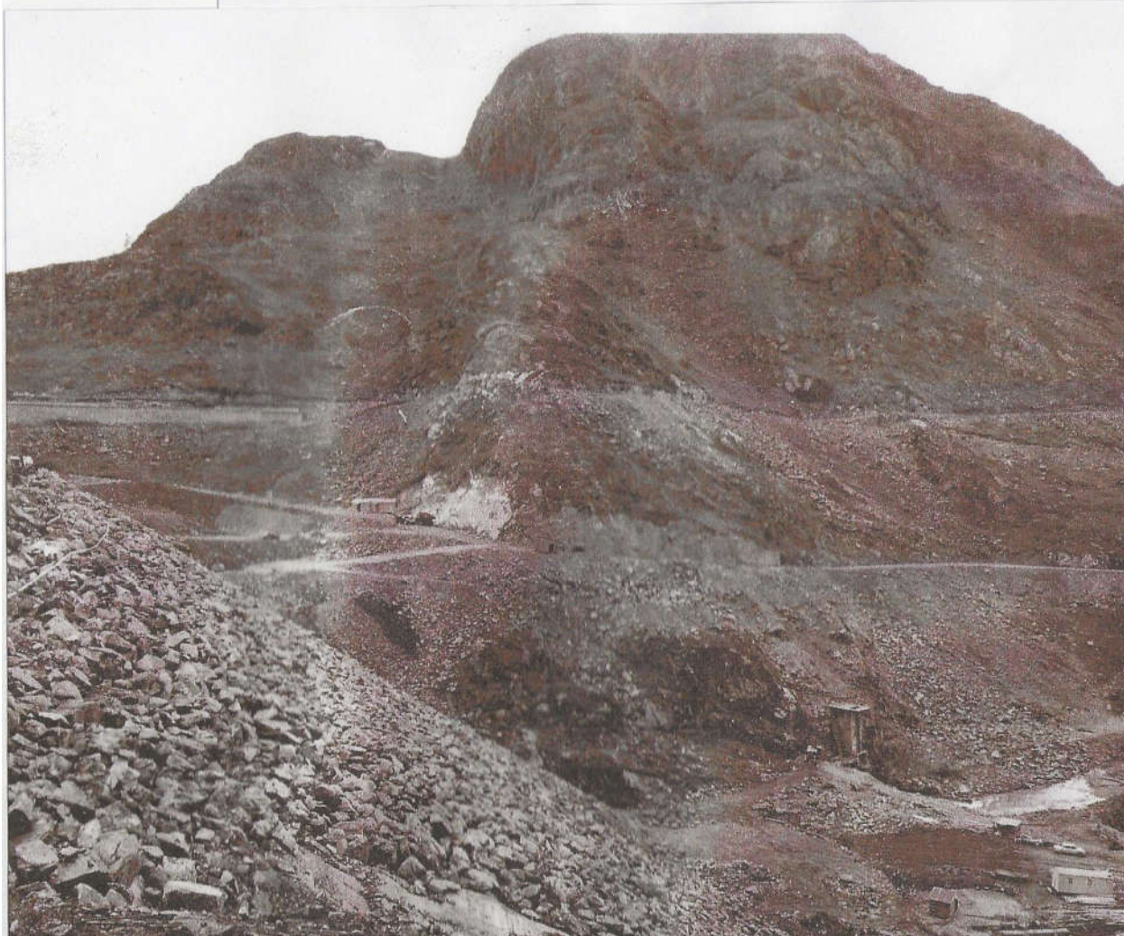
Valldalsdammen under byggjing 1964. Kløvsnuten på Nordsida. Eit farleg nutparti med snøskred og steinsprang.
