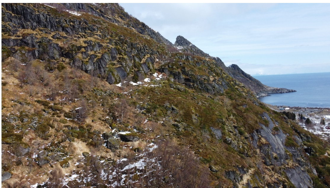
Figur 3-4 Parti øst for elven fra Moskenesvatnet med høyere oppsprekkingsgrad enn ellers i fjellsiden.
