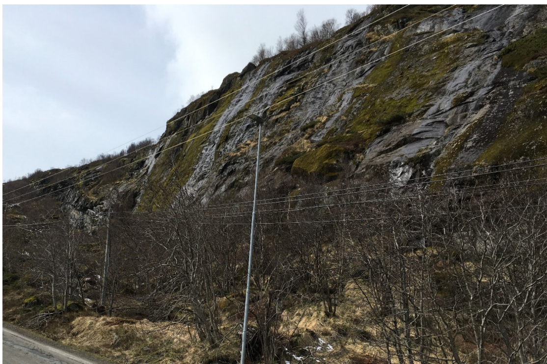
Figur 3-2 Berget er mange steder massivt med lav oppsprekking.
