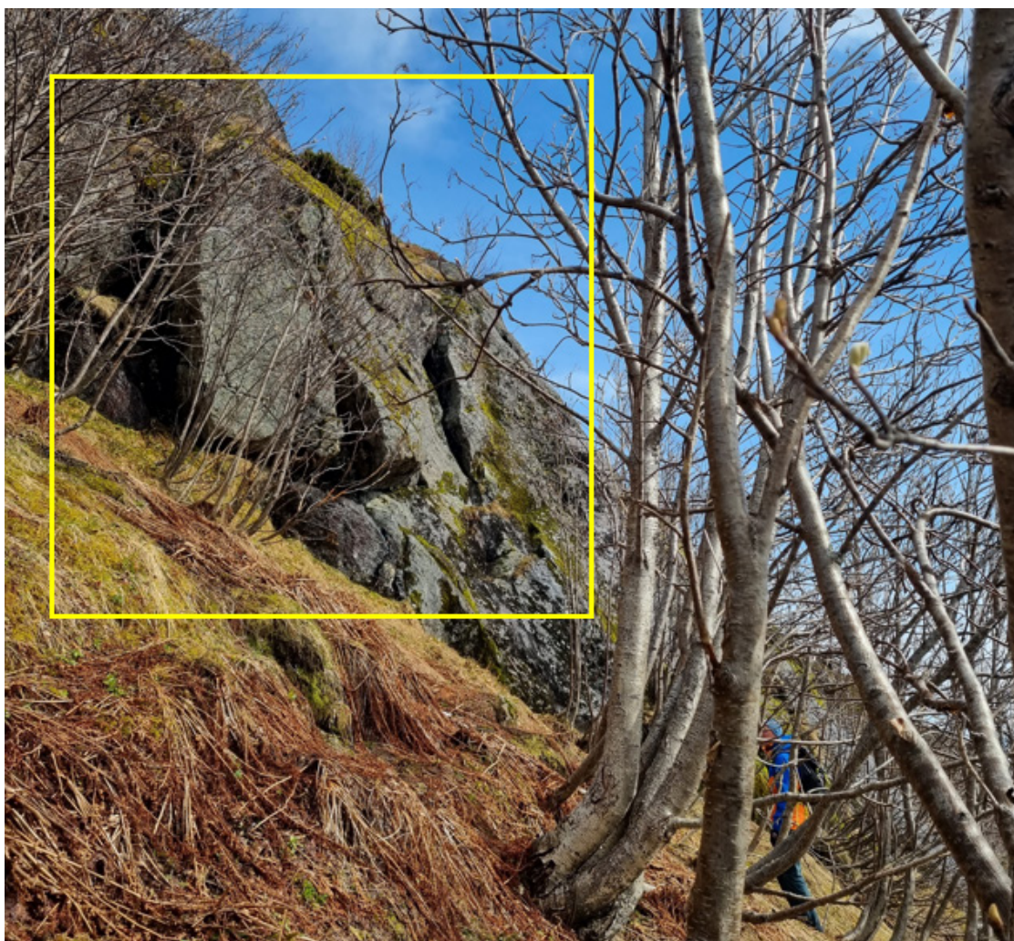
Figur 3-5 Avløst blokk (ca. 10 m 3 ).
