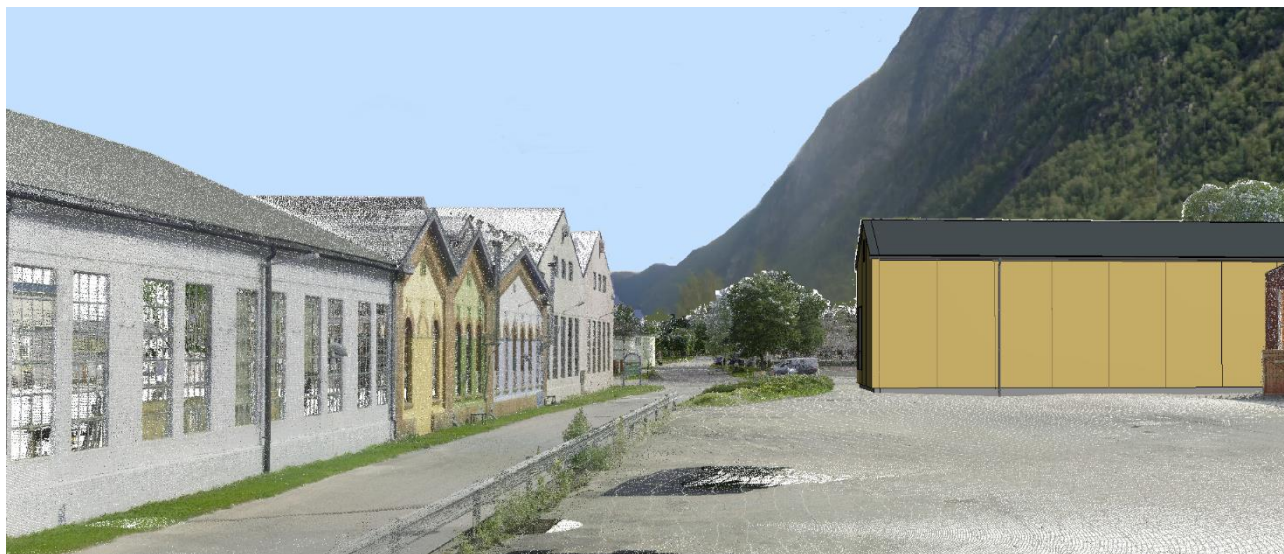
Figur 5-2: Fasadebilde av Vestfjorddalen transformatorstasjon, vestlig side.
