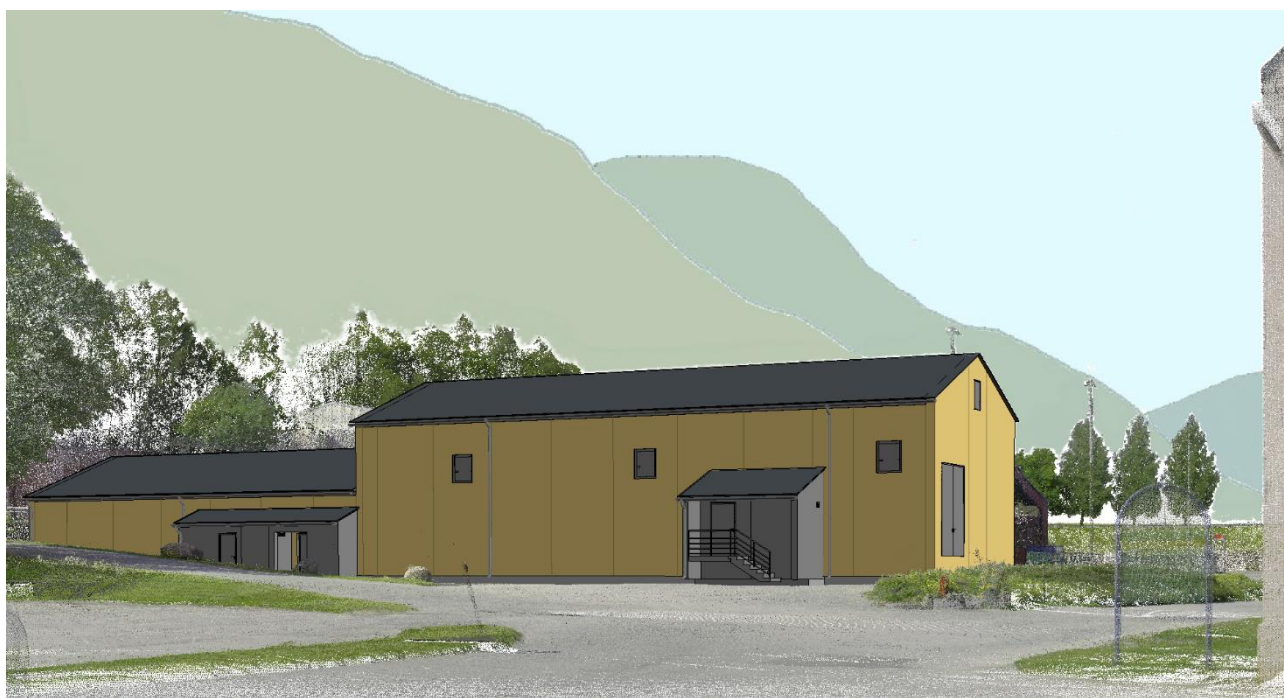
Figur 5-4: Fasadebilde av Vestfjorddalen transformatorstasjon, fra nord-østlig side av bygningen.
