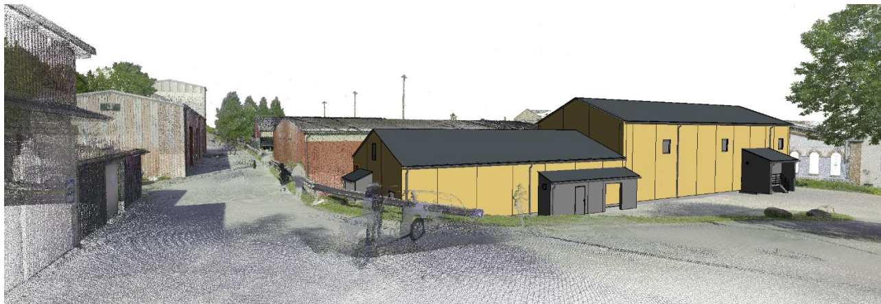
Figur 5-1. Fasadebilde av Vestfjorddalen transformatorstasjon, sørlig/østlig side.
