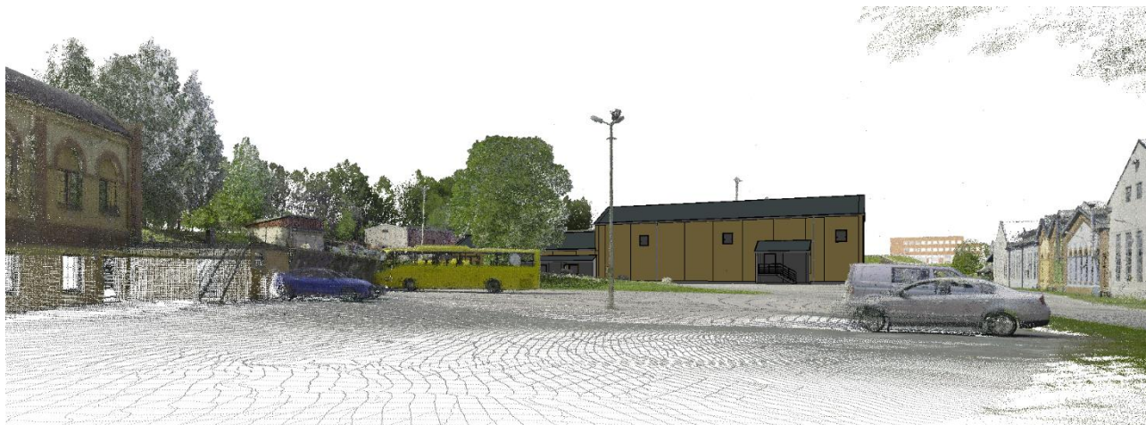
Figur 5-3: Fasadebilde av Vestfjorddalen transformatorstasjon, østlig side fra parkeringsplass.
