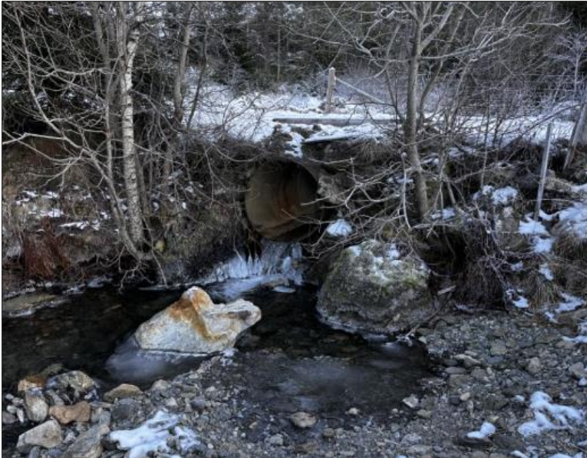
Figur 12 Kulvert i sideelv. Diameter ca. 1,5 meter.
