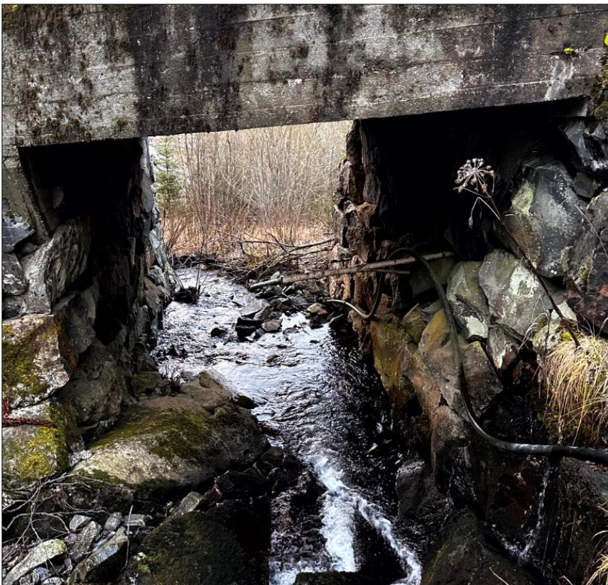
Figur 13 Bru over sidebekk. Bredde 3,3 meter, høyde 3,1 meter.
