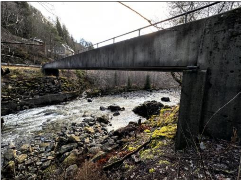
Figur 11 Gangbru over Storelvi nord i analyseområdet.
