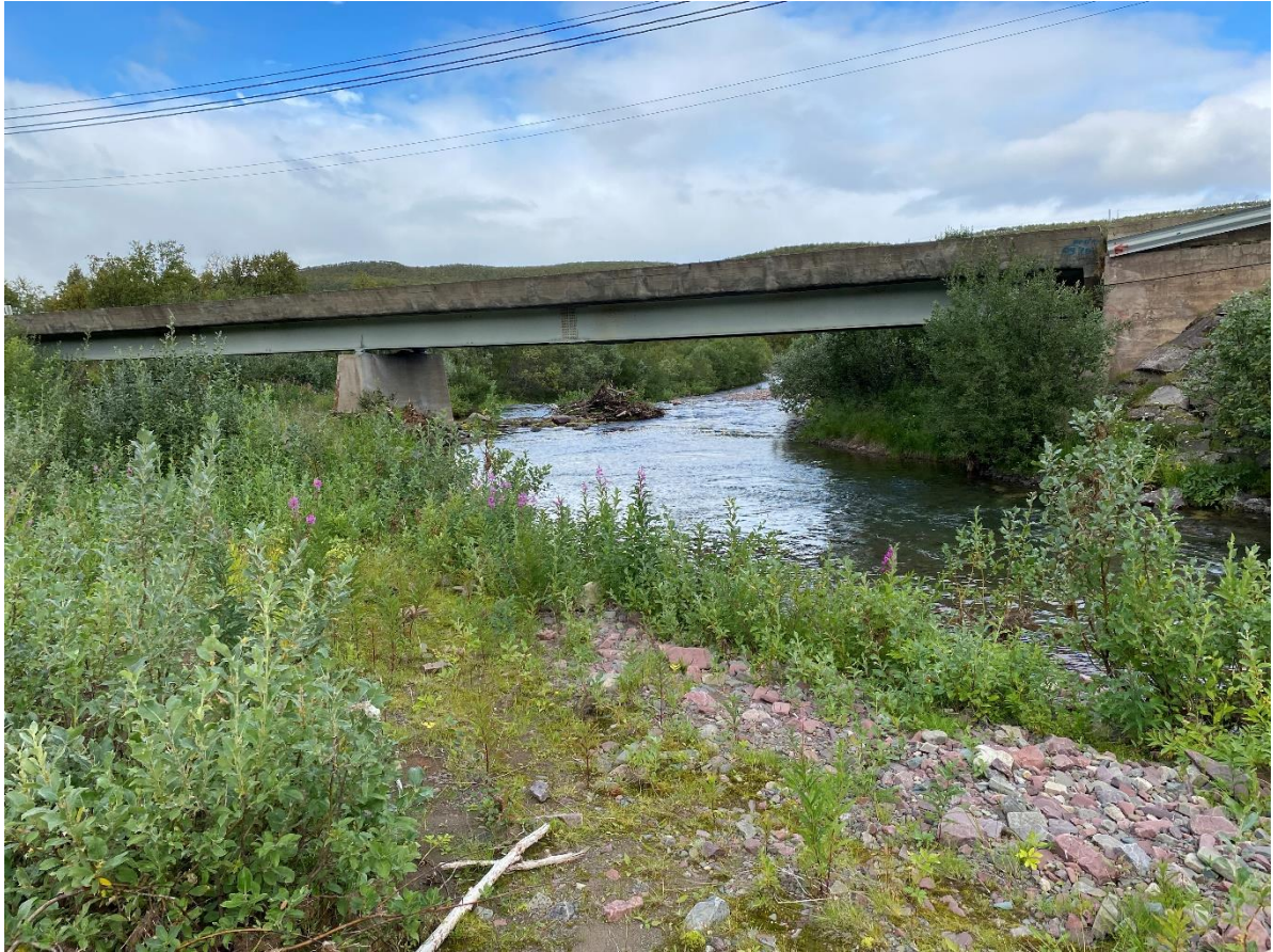
Bilde 5-1. Eksisterende bru, bilde tatt på sørsiden av brua og i strømningsretning.
