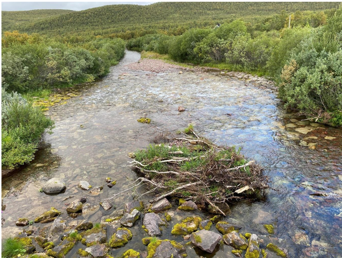
Bilde 5-3. Bilde tatt fra brua og nedstrøms. Markert flatterskel og brekk-kant ca. 30 meter nedstrøms bru. Deretter større fall og innsnevring ca. 55 meter nedstrøms. Trær og avsetninger i midten av bildet er rett bak brupilar.
