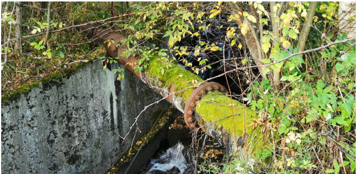
Figur 2 – Ledning i dagen ved bekkekryssing
