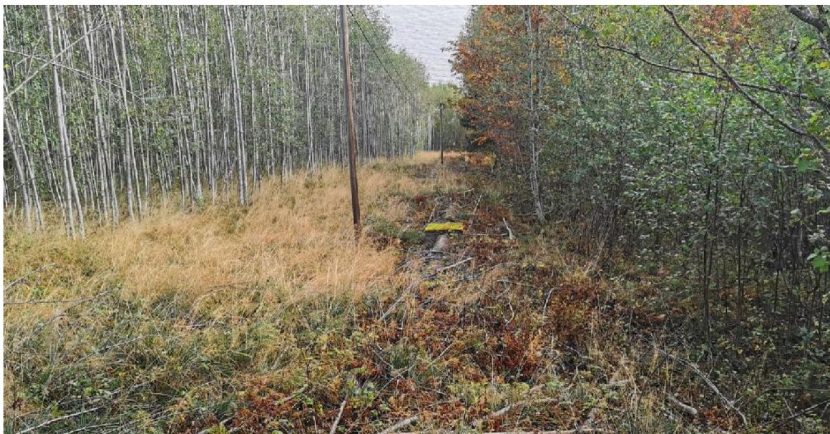
Figur 11 – Ledningstrase med ledning delvis nedgravd og delvis i dagen
