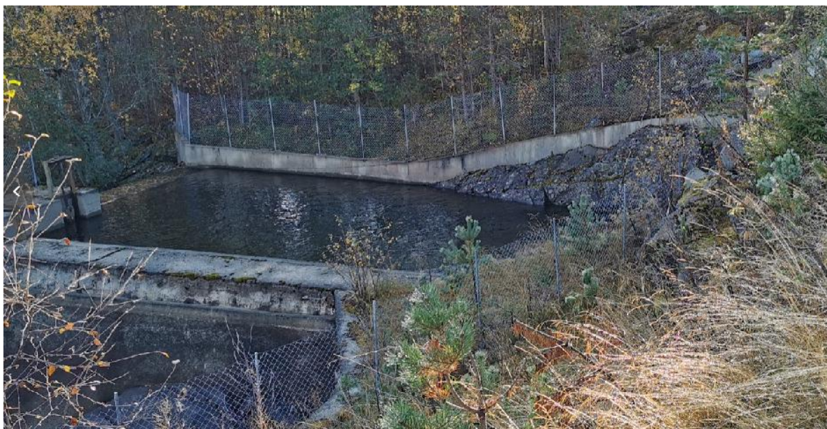
Figur 23 – Inntaksdam, overløp og innløp Meisalelva sett fra sørvest
