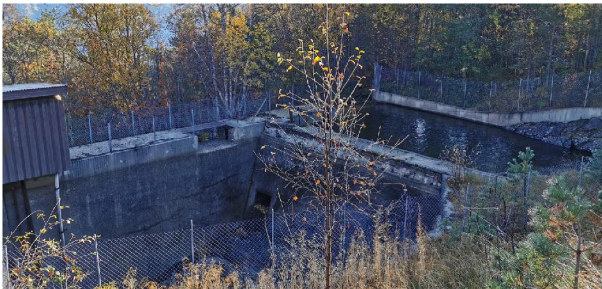
Figur 22 – Inntaksdam, overløp og innløp Meisalelva sett fra sørvest
