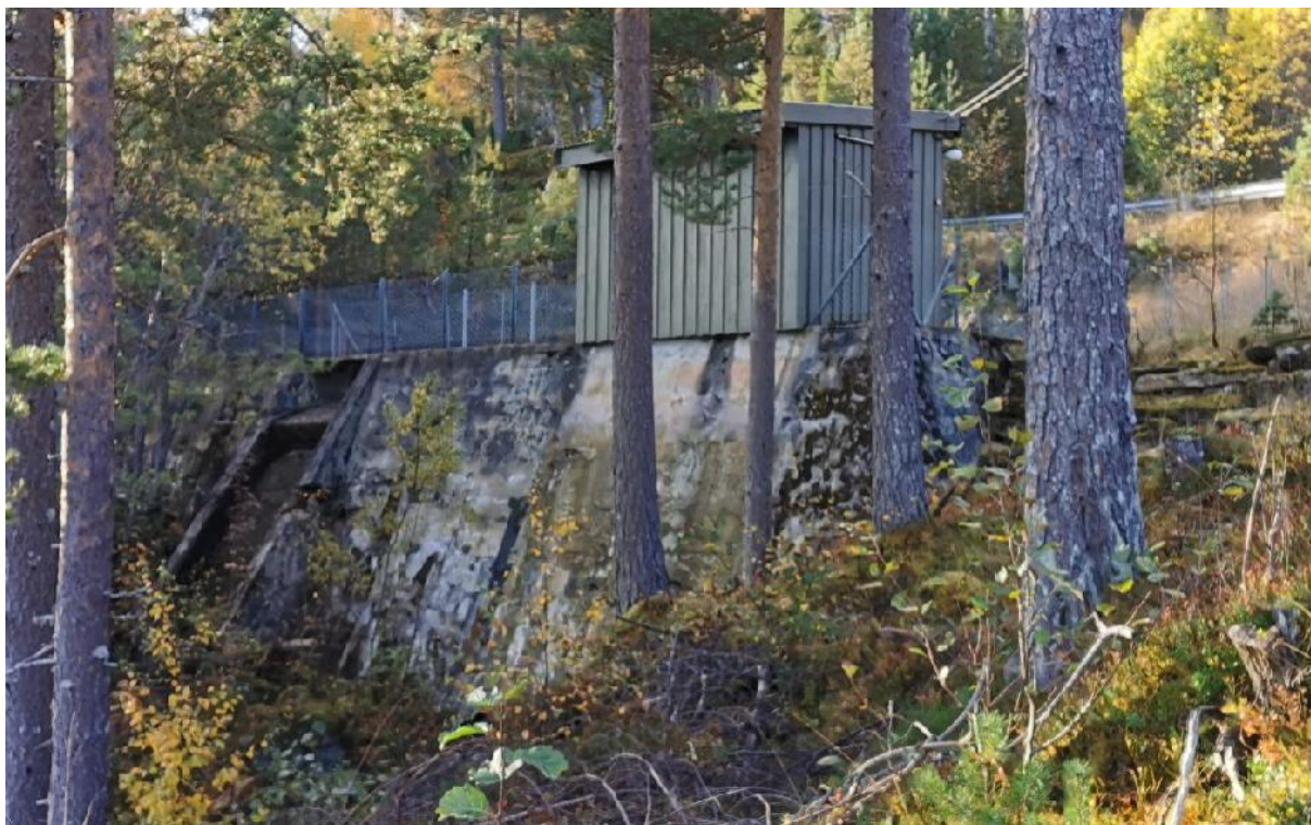
Figur 16 – Inntaksdam og lukehus sett fra nord
