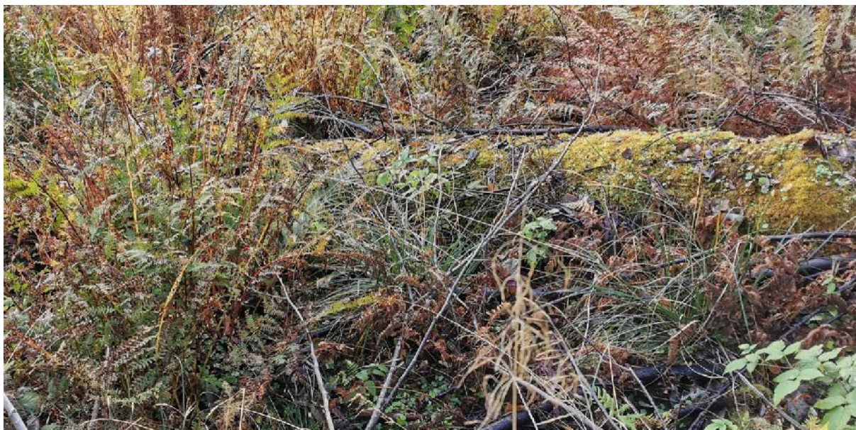
Figur 5 – Delvis nedgravd ledning
