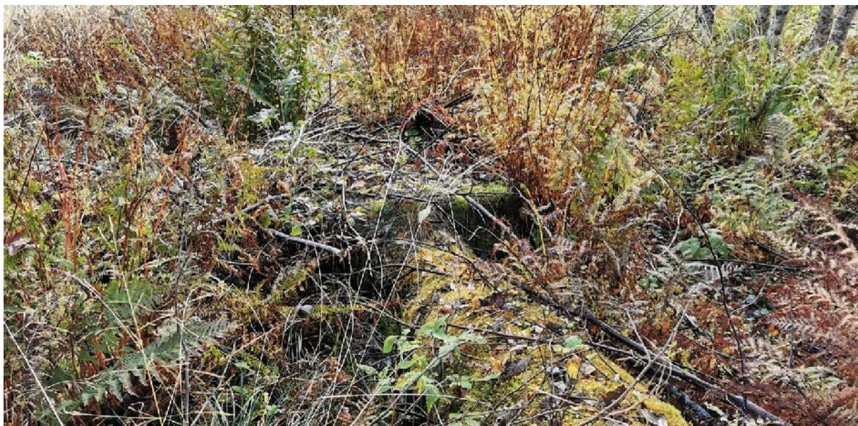
Figur 7 – Delvis nedgrav ledning og betongfundament
