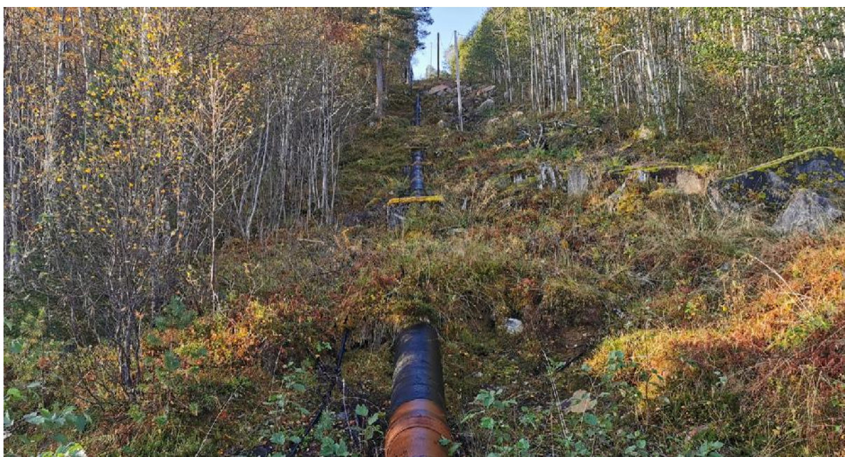
Figur 14 – Ledningstrase med ledning delvis nedgravd og delvis i dagen
