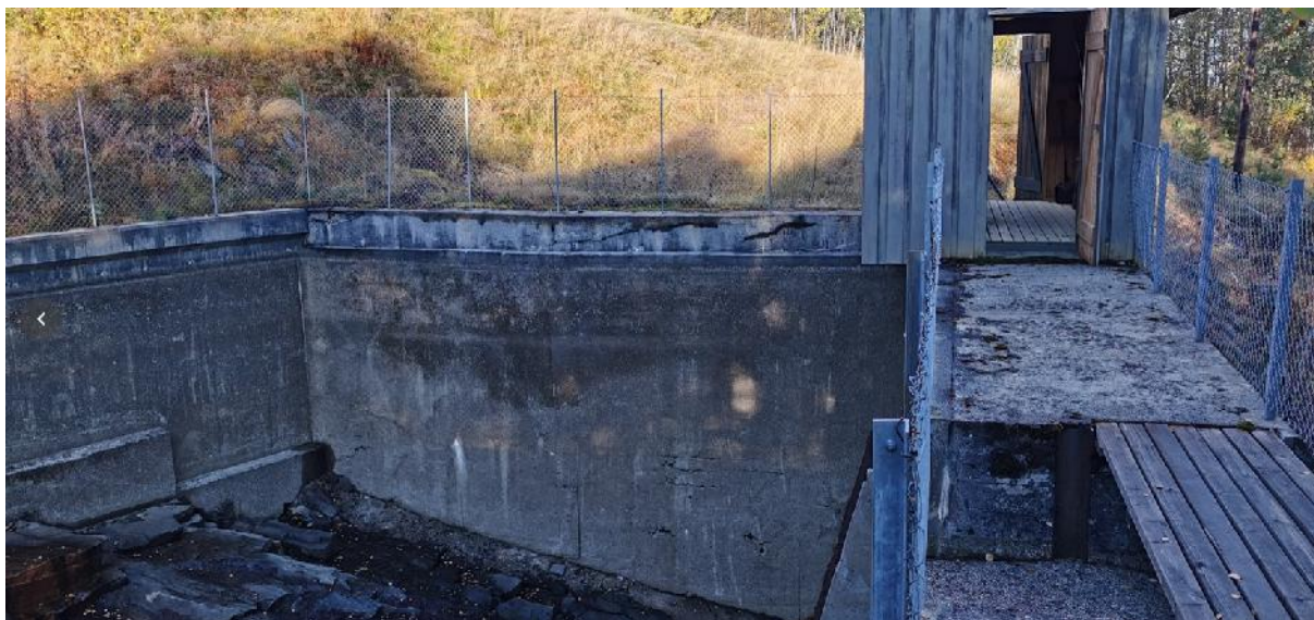
Figur 20 – Inntaksdam og lukehus sett fra øst
