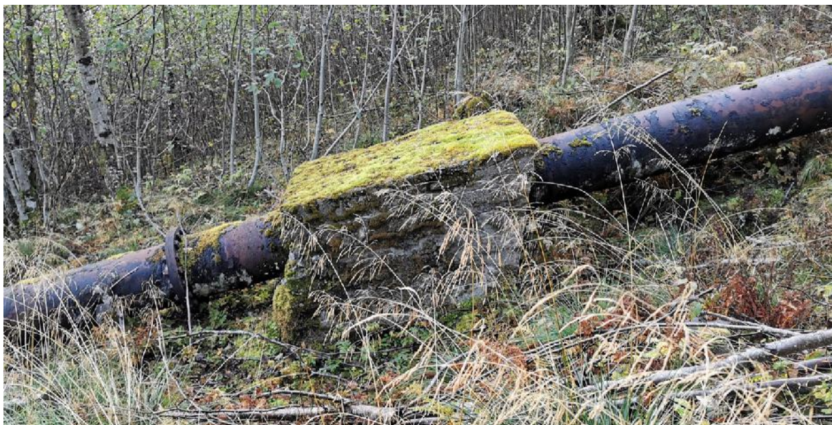
Figur 9 – Ledning i dagen og betongfundament
