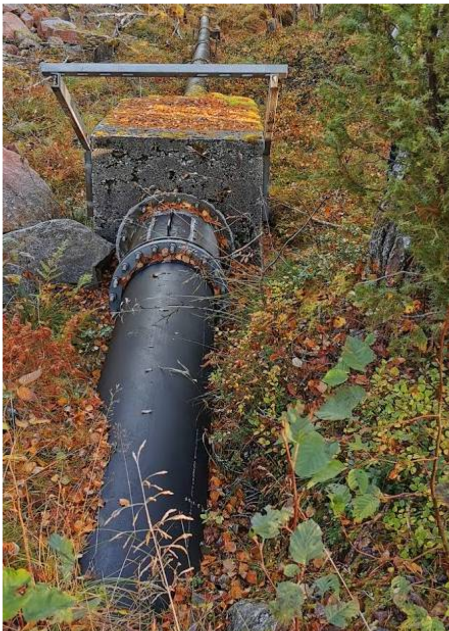
Figur 15 – Overgang mellom duktilt støpejernsrør og PE-rør
