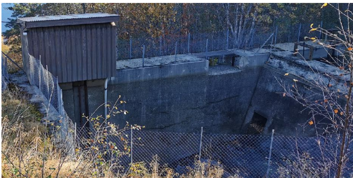
Figur 21 – Inntaksdam og lukehus sett fra sør
