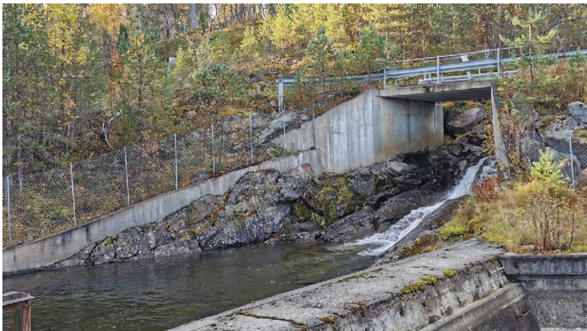
Figur 18 – Meisalelva sitt innløp til overløp og inntaksdam
