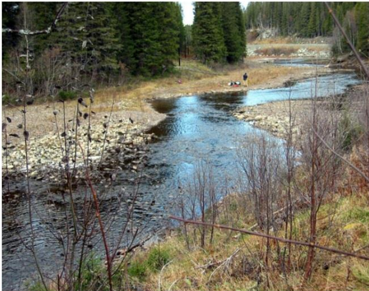
Figur 21. Eksempel på "elv i elv" tiltak i en elvestreking med sterkt redusert vannføring og brei elveseng. Fra Dalåa i Stjørdalsvassdraget, Nord-Trøndelag. Den restaurerte elvestrekningen svinger seg i elveløpet og veksler mellom små stryk og kulper. Foto: Knut Alfredsén
