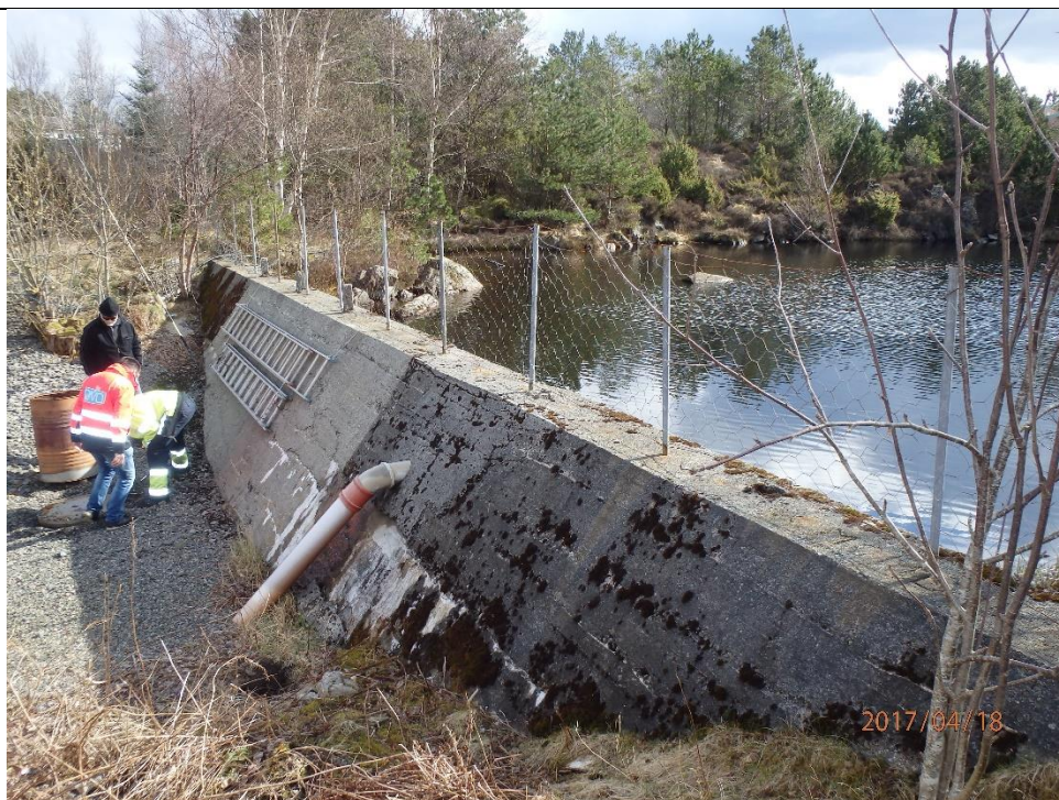
Oversiktsbilde av dammen sett fra venstre vederlag.
