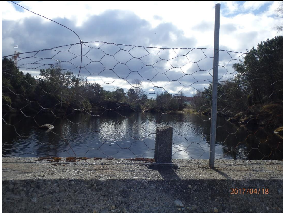
Oversiktsbilde av magasinet sett fra damkrone.
