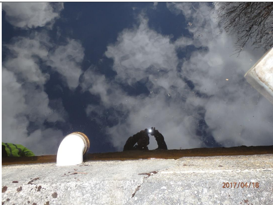
Dykker ved innløp av 160mm rør.
